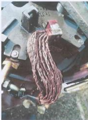
Jedna od oštećenih pletenica zvježišta
