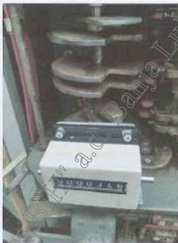
Mjesto montaže i pribavljeni brojačnik koji nije bilo moguće ugraditi
