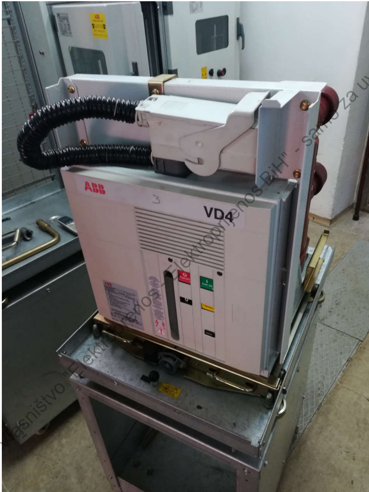
Prilog br. 3 - Izgled postojećeg prekidača 10 kV
