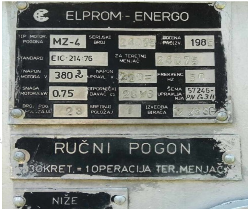
Slika br.1 Natpisna pločica sa regulacione preklapke
