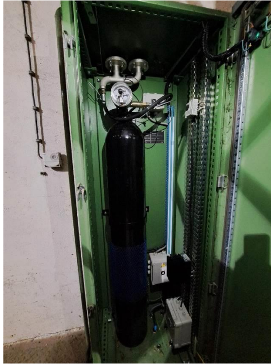
Slika 1. Spremnik N 2 sistema za brzo gašenje požara - SERGI
