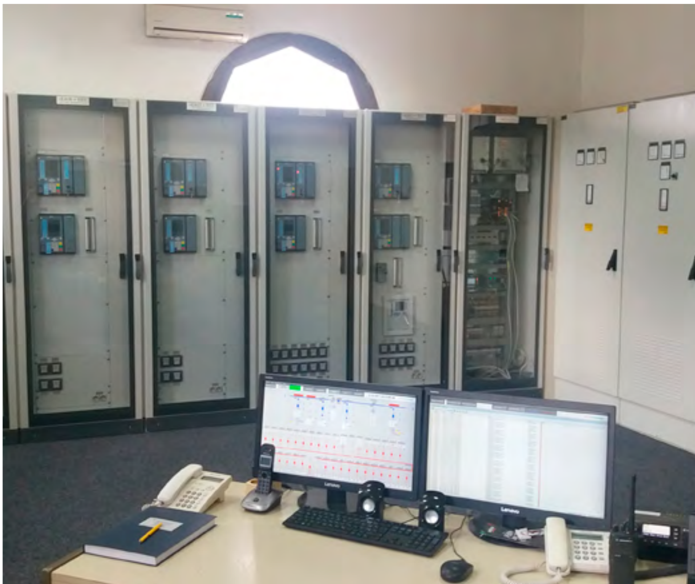
Slika 8. Novi ormari zaštite i upravljanja
