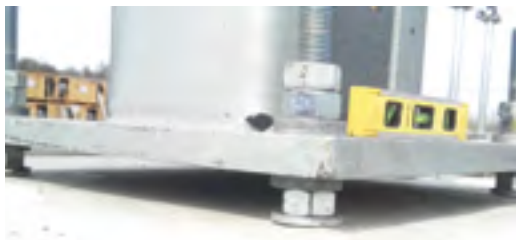
Nosač 110 kV prekidača, ankerisan nivelacionim vijcima prema EU standardima
