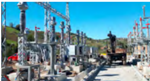
Slika 3. Montaža VN aparata na čeličnu konstrukciju
