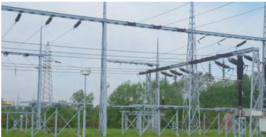
Slika 2. TS 110 kV HAK nakon demontaže stare opreme
