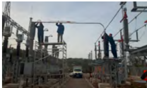
Slika 4. Montaža cijevnih prelaza preko transportnih staza u postrojenju 110 kV
