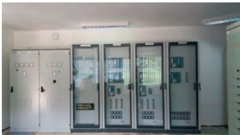
Slika 3. Ugrađeni novi ormari za zaštitu i upravljanje
