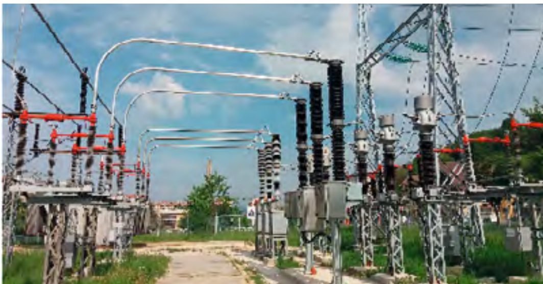
Slika 2. TS Sarajevo 15 – dio rekonstruisanog postrojenja
