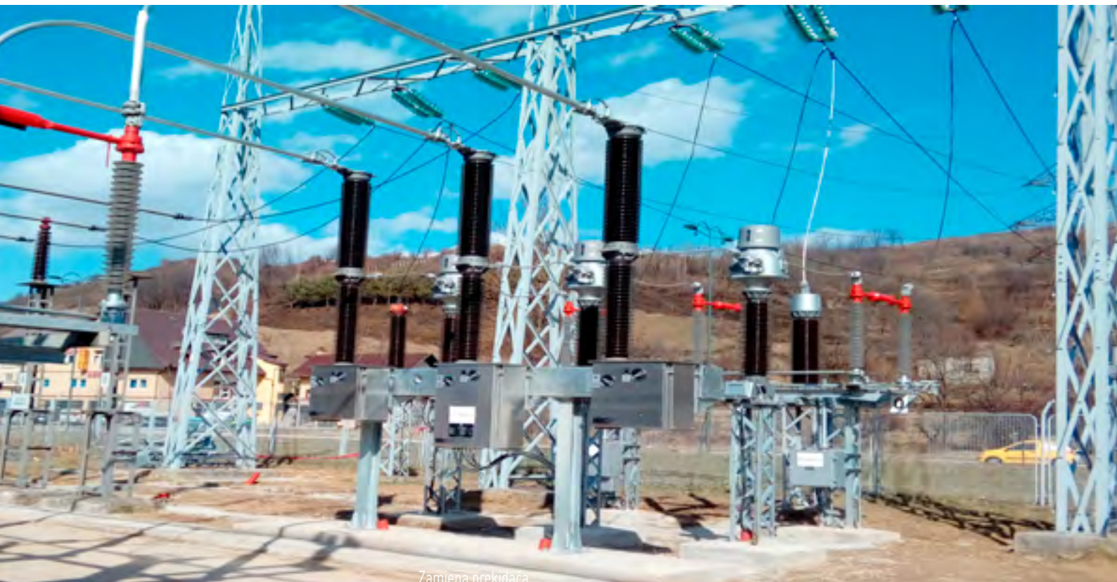
Slika 1. Dio vanjskog postrojenja koji je bio predmet rekonstrukcije
