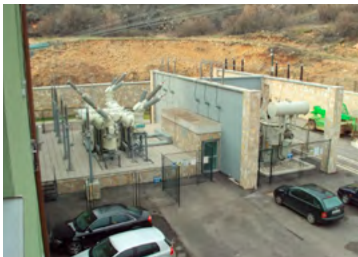
Slika 8. Hibridno postrojenje 110 kV (tip 8DN8, SIEMENS) u HE Mostarsko blato
