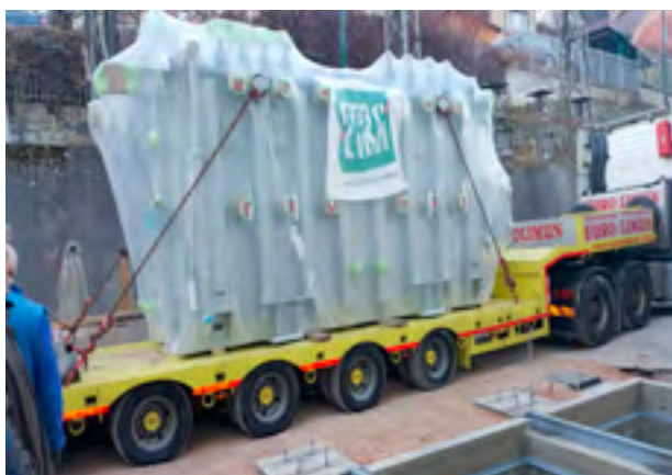
Slika 3. Transport novog transformatora
