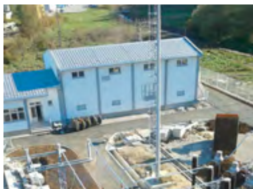
Slika 7. Komandno-pogonska zgrada i dio kruga TS
