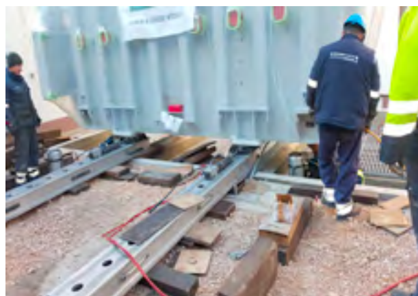
Slika 4. Pretovar novog transformatora na temelje
