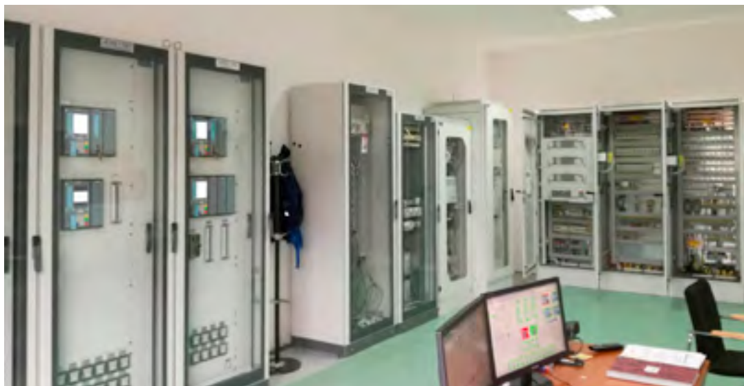
Slika 6. Komandna prostorija nove TS 110/35/10(20) kV Bužim
