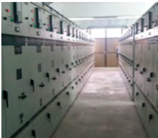
Slika 6. Novo SN postrojenje
