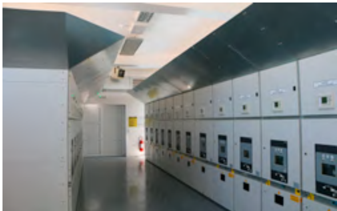
Slika 3. - SN postrojenje
