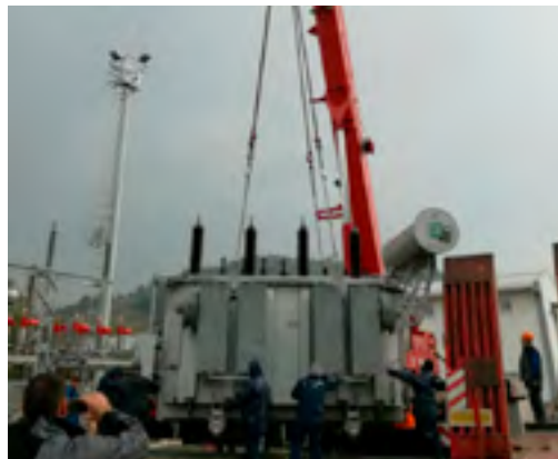
Slika 5. Istovar energetskeg transformatora ETRA na kadu trafoa u TS 110/35/10 kV Bužim
