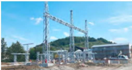
Slika 2. Montaža konstrukcije aparata u 110 kV postrojenju
