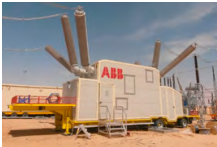
Slika 4. Mobilna 400 kV TS – Touggurt Alžir, proizvođač ABB
