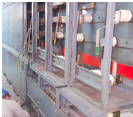
Slika 7. Demontaža starog SN postrojenja
