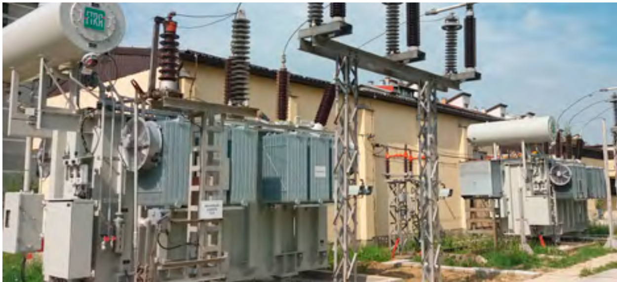
Slika 2. Ugrađeni novi transformatori 40 MVA
