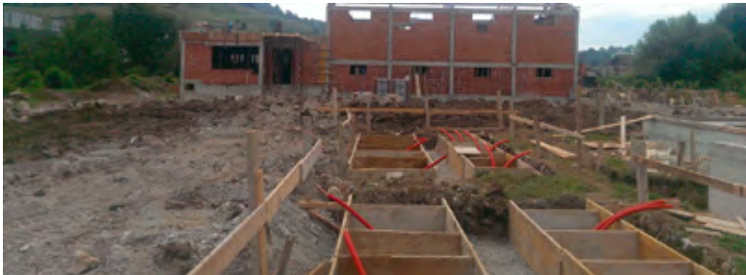
Slika 1. Radovi na platou, izgradnji komandno-pogonske zgrade i temelja VN aparata
