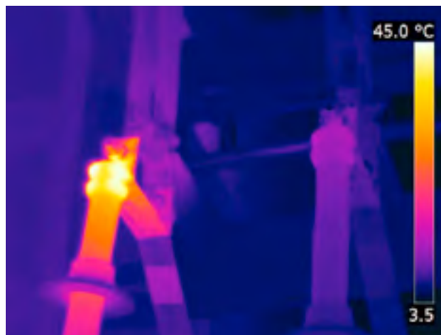
Слика 2. Примјена термографије у електроенергетици
