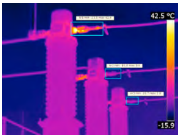
Слика 3. Прегријавање на контакту струјног мјерног трансформатора
