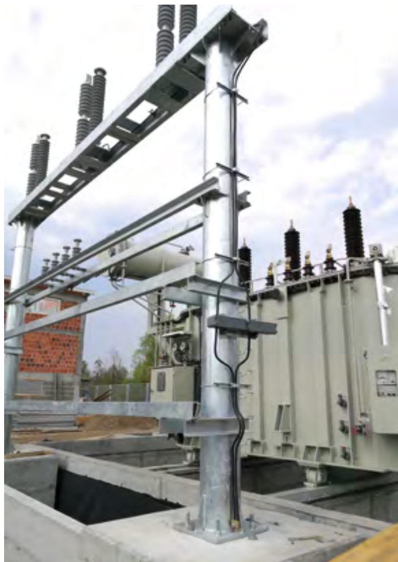
Detalj vođenja kablova 110 kV odvodnika prenapona
