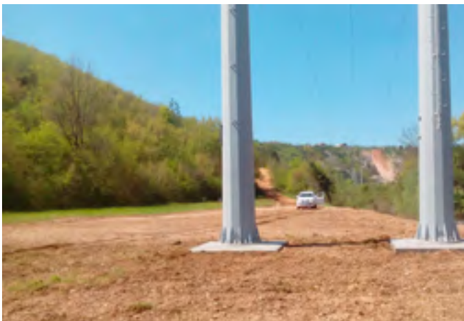
DV 110 kV Mostar 4 – Š.Brijeg (portalni stup 68A)
