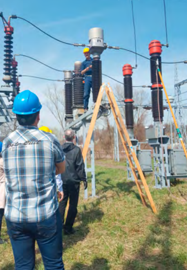
Slika 3. Ispitivanje opreme u TS 110 kV HAK
