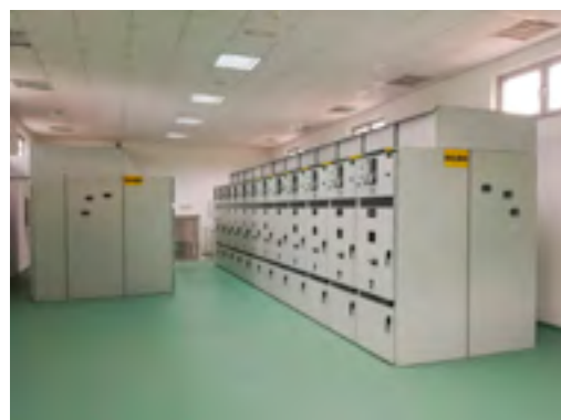
Slika 8. SN postrojenje 10(20) i 35 kV
