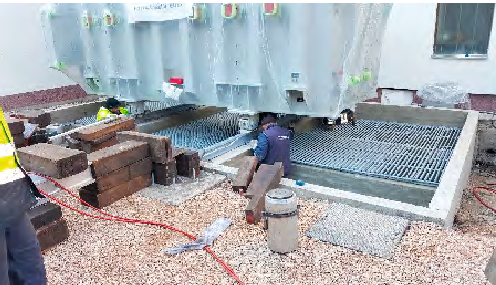
Slika 1. Montaža novog transformatora u TS Sarajevo 13
