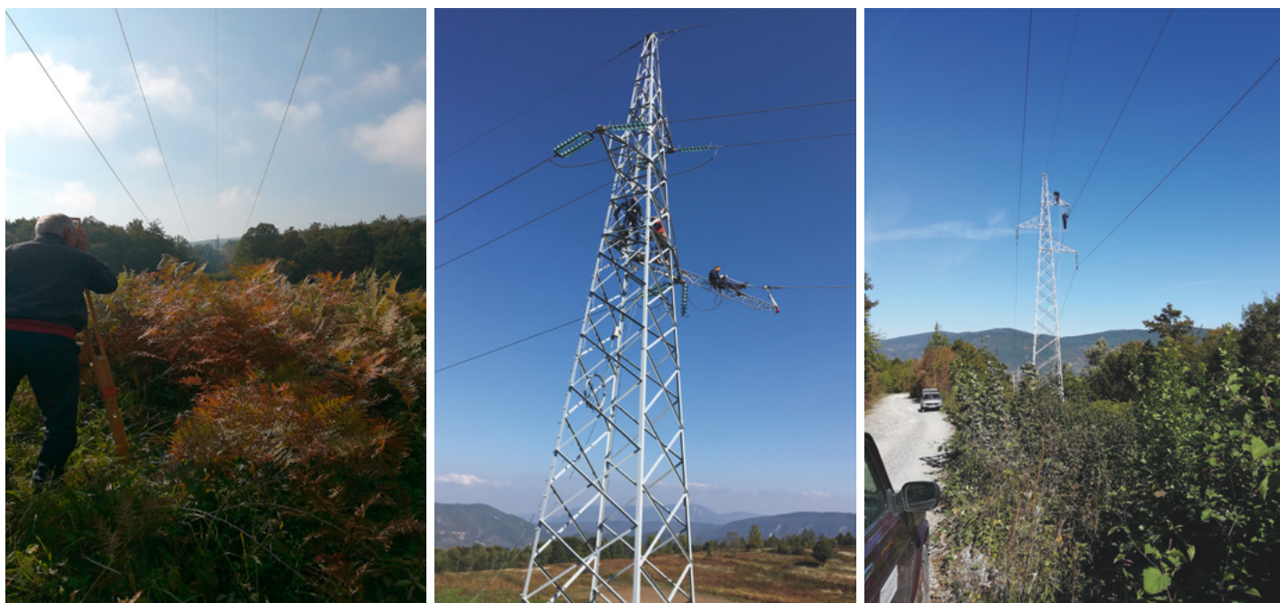
Slika 8. Mjerenje i kontrola provjesa
