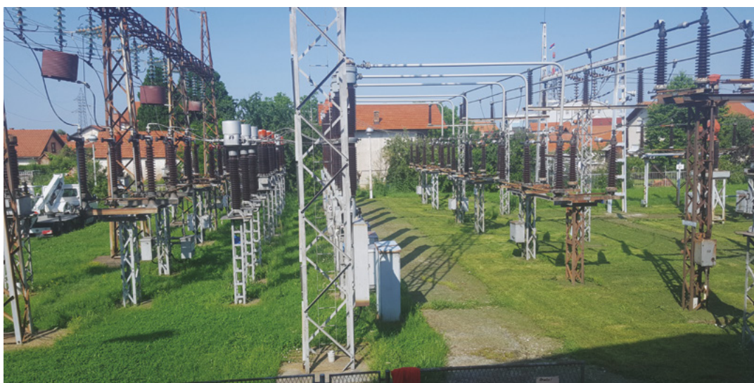
Slika 1. TS prije rekonstrukcije
