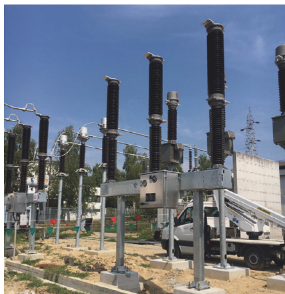
Slika 9. Montaža prekidača 123 kV u TP1 [2. faza]
