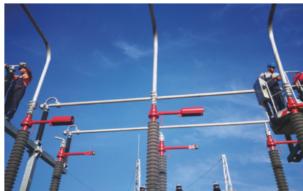
Slika 3. Služba za održavanje RP na montaži sabirnica 110 kV na nove nosače (1. faza)
