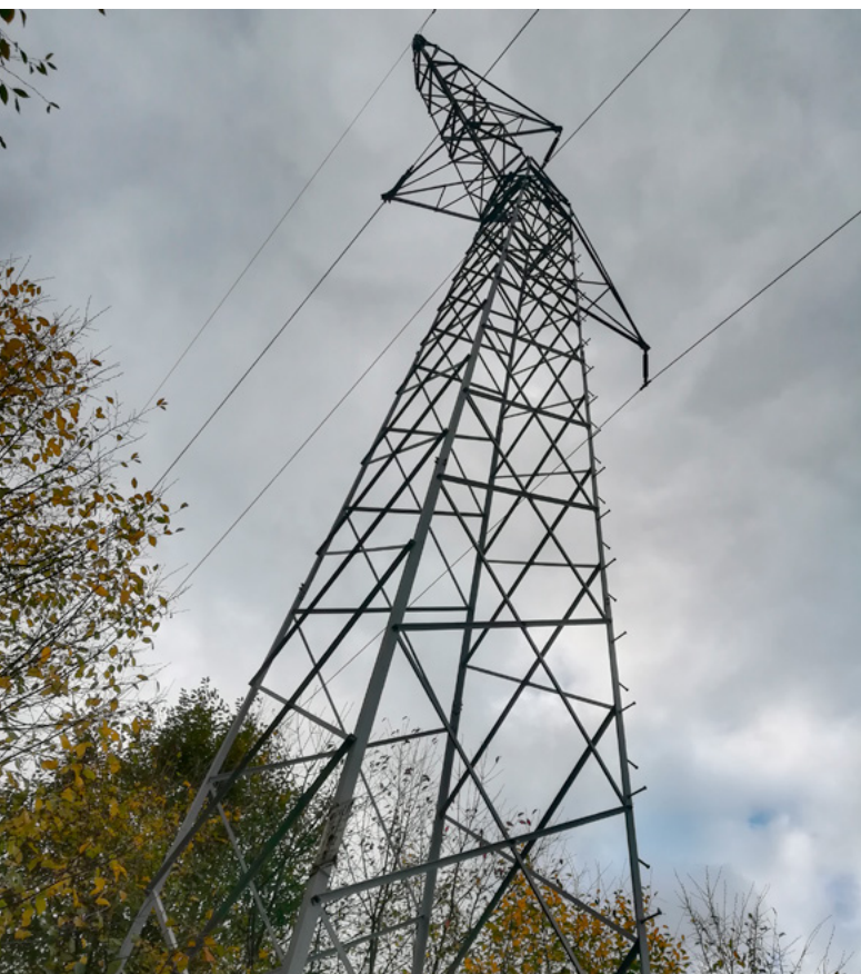
Slika 2. Oštećenje stuba br. 142 „I 6 “ na DV 110 kV Prijedor 2 – Bosanska Krupa
