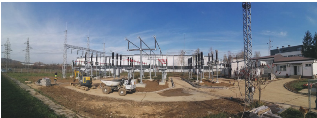
Slika 12. Završni radovi na uređenju terena
