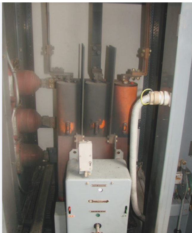
Prenapon uz suradnju sa vlagom može izazvati preskok
