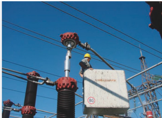
Na +39° C: mikropukotine, starost izolatora i... havarija
