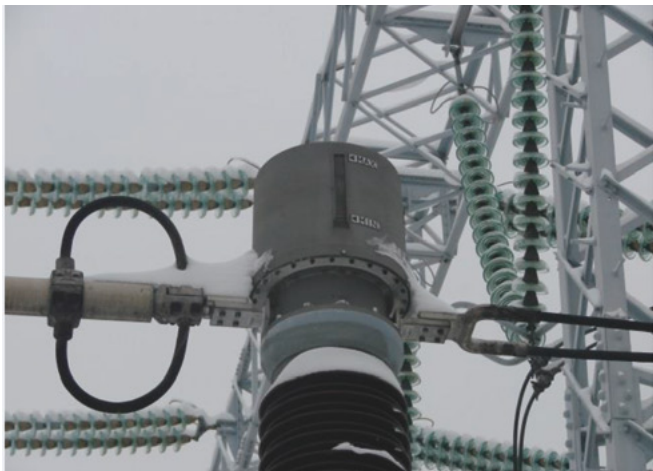
Na -15° C: Da li je nivo ulja na minimumu ili maksimumu
