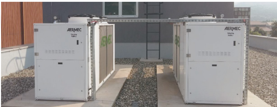
Slika 6. Toplotne pumpe
