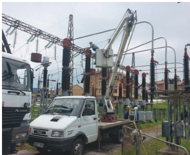
Zamjena pola prekidača HPGE 11 – TS Pale (2016. godina)
