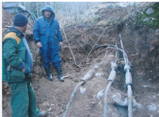
Spojница otkopana i sanacija može započeti
