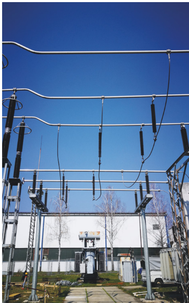
Slika 1. Kruta 110 kV veza trafo polja - prije rekonstrukcije
