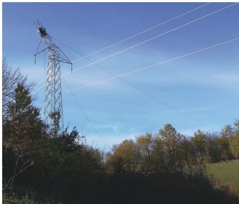
Slika 3. Sanacija stuba br. 142 „I 6 “ na DV 110 kV Prijedor 2 – Bosanska Krupa
