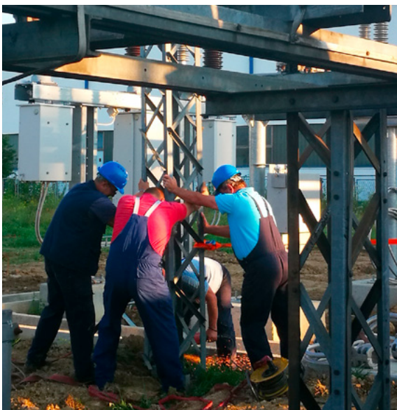
Slika 6. Služba za održavanje RP na montaži centralnog nosača sabirnica 110 kV (kraj 1. faze)
