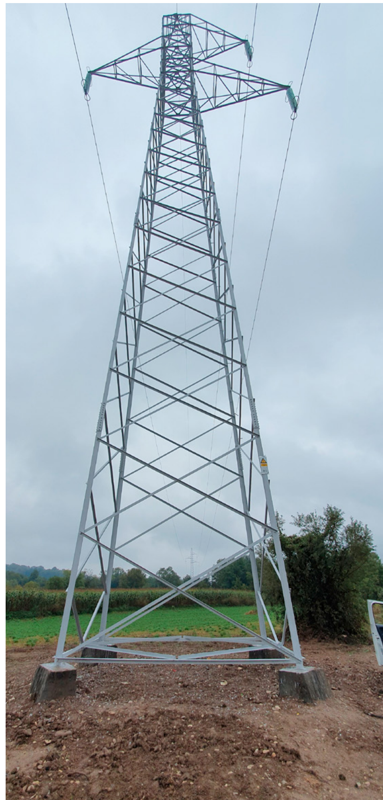
Slika 4. Novoizgrađeno stubno mjesto broj 89
