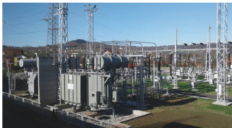
Slika 2a. Postrojenje 110 kV nakon rekonstrukcije
