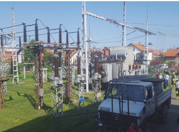
Slika 2. Početak izvođenja radova
