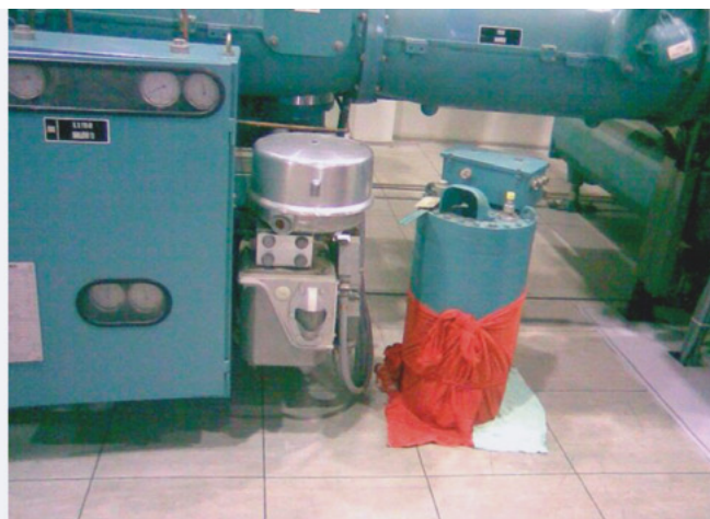
Kada se mora, i Siemensov MOP se demontira (ali ne preporučuje se bez obuke)
