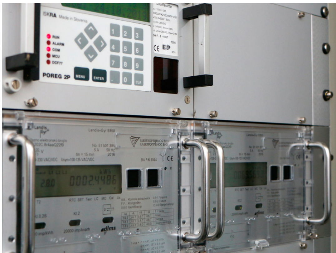
Oprema obračunskog mjernog mjesta (registrator podataka POREG 2P i nova multifunkcijska brojila Landis+Gyr)
