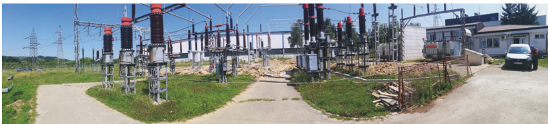
Slika 11. VN postrojenje tokom rekonstrukcije (1. faza)
