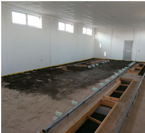
Slika 4. Izgradnja novog postrojenja 10 kV
