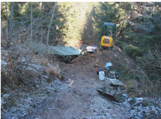
Priprema za sanaciju kvara na kablu 110 kV RP Pratače – TS Sarajevo 14 nakon devastacije trase
