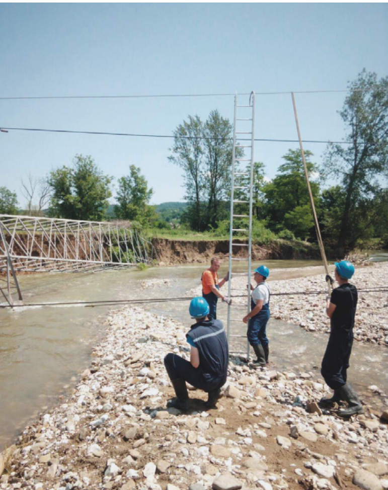
Slika 2. Radovi na demontaži konstrukcije stuba broj 89 iz korita rijeke Tinje
