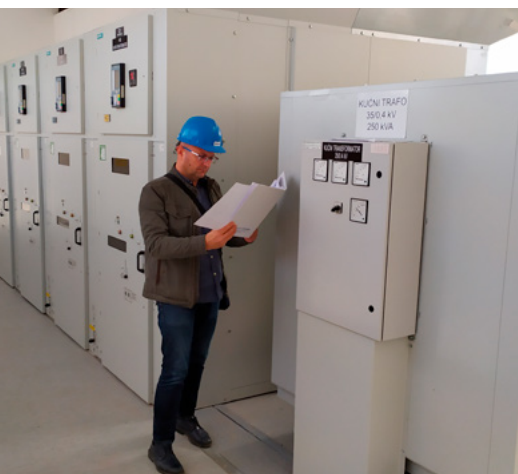
Slika 2. Mirsad Arapčić, voditelj projekta. Novo postrojenje 35 kV.
