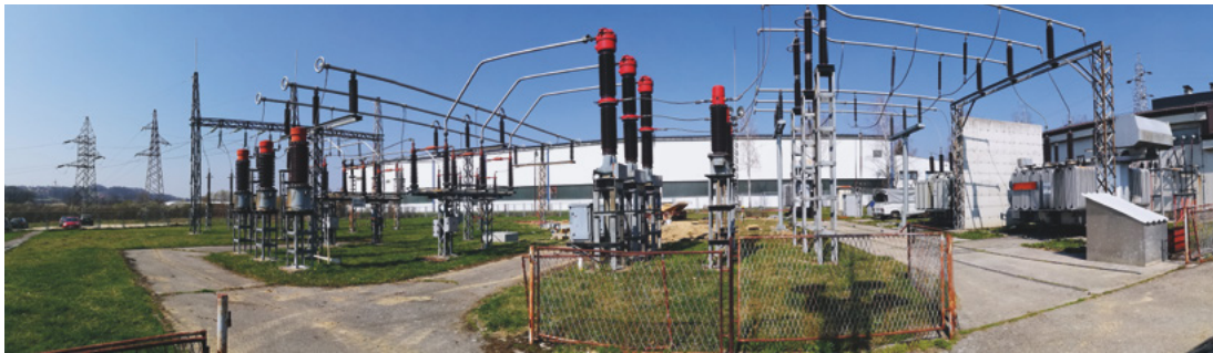
Slika 10. VN postrojenje prije rekonstrukcije
