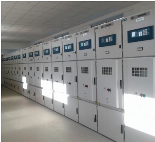
Slika 4a i b. Novo postrojenje 10 kV
