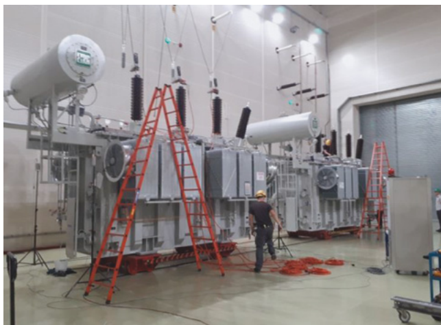
Ispitivanje transformatora u fabrici (ETRA)
