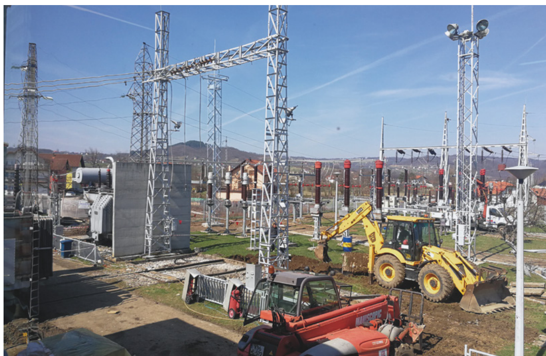
Slika 3. Demontaža stare primarne opreme u postrojenju 110 kV
