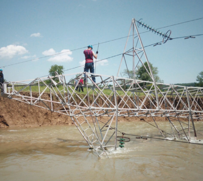
Slika 3. Radovi na demontaži vodiča stuba broj 89
