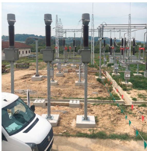
Slika 8. Elektromontažni radovi na TP 1 i DV 110 kV Derventa [2. faza]
