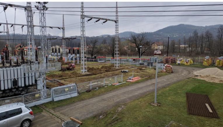
Slika 1. Početak rekonstrukcije postrojenja 110 kV
