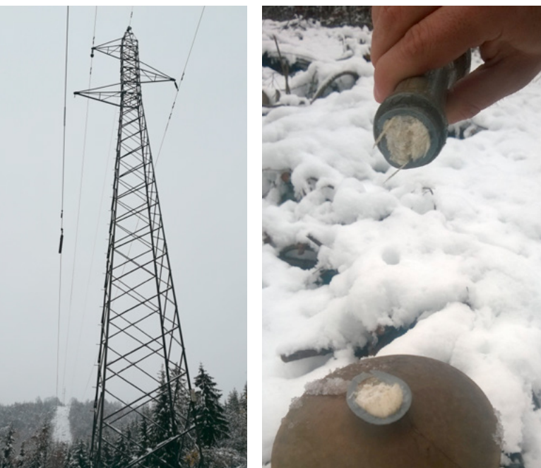
Slika 4. Sanacija prelomljenog polimernog izolatora na DV 110 kV Bosanska Krupa - Bihać, SM 150
