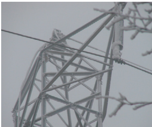
Slika 6. Rasponi prekida OPGW između dva nosiva stuba i mjesto prekida OPGW
