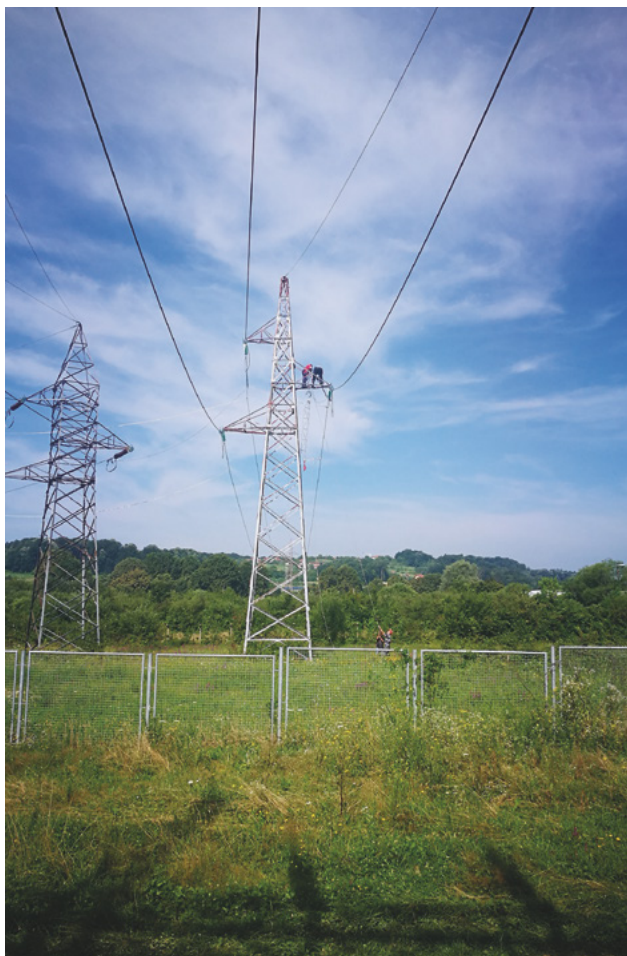
Slika 2. Služba za održavanje DV na montaži krute veze TS Prnjavor sa DV 110 kV Ukrina i DV 110 kV Derventa (1. faza)
