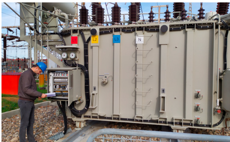
Slika 3. Edin Suljić, inž. saradnik u Službi za RP. Novi transformator TR 2 110/35/10(20) kV.
