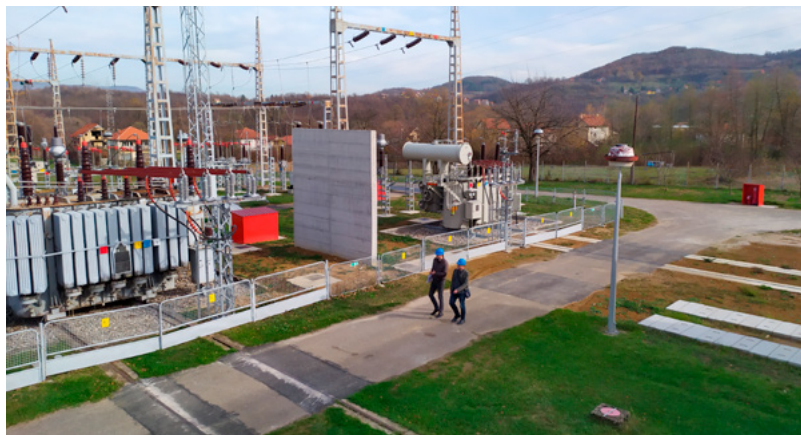
Slika 1a. Postrojenje 110 kV nakon rekonstrukcije
