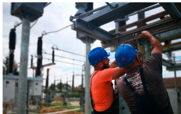
Slika 4. Služba za održavanje RP na elektromontažnim radovima na ekvipotencijalizaciji metalnih masa sa novim uzemljivačem TS
