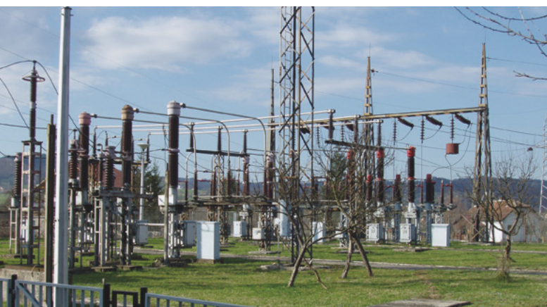
Slika 2. Postrojenje 110 kV prije rekonstrukcije
