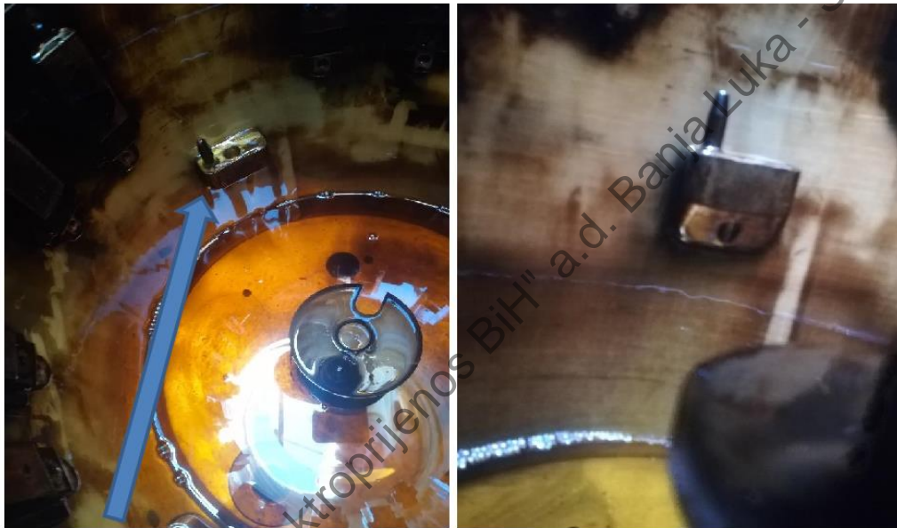
Otpušteni nosač teretne preklopke kroz koji prodire ulje iz transformatora u cilindar i talog koji se ne može oprati na cilindru teretne preklopke
