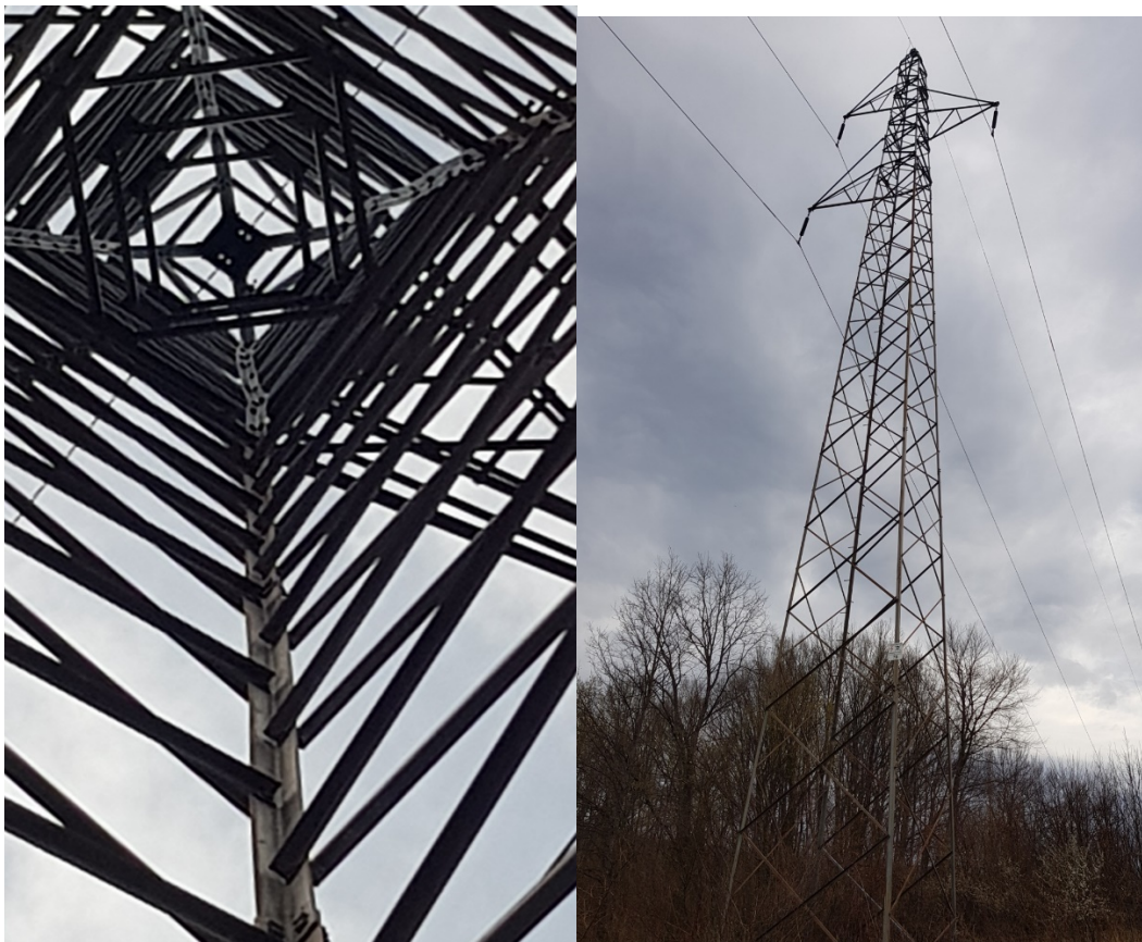
Slika 2. Deformacija dva pojasnika na SM 78
