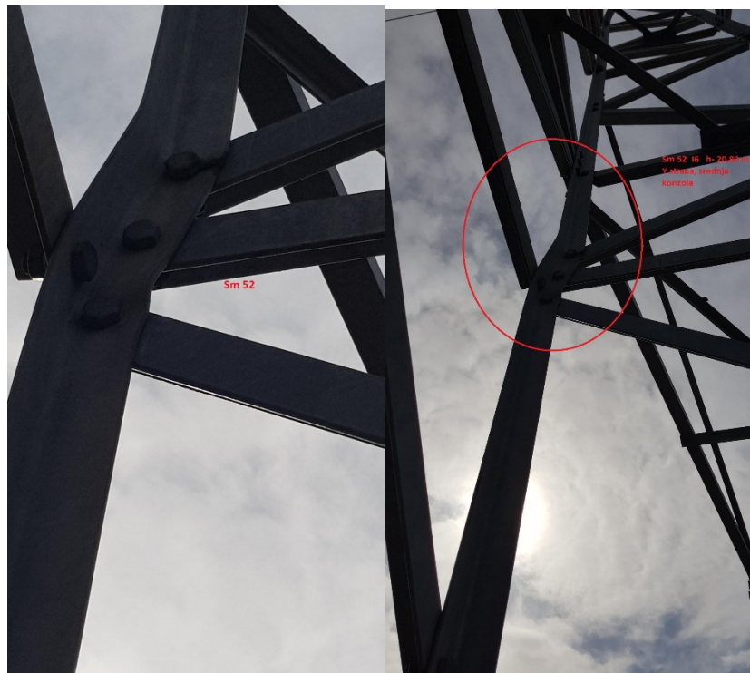
Slika 1. Deformacija dva pojasnika na SM 52
