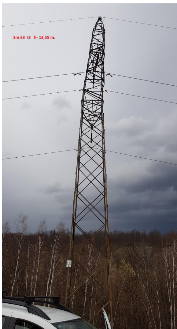
Slika 3. Deformacija SM 63
