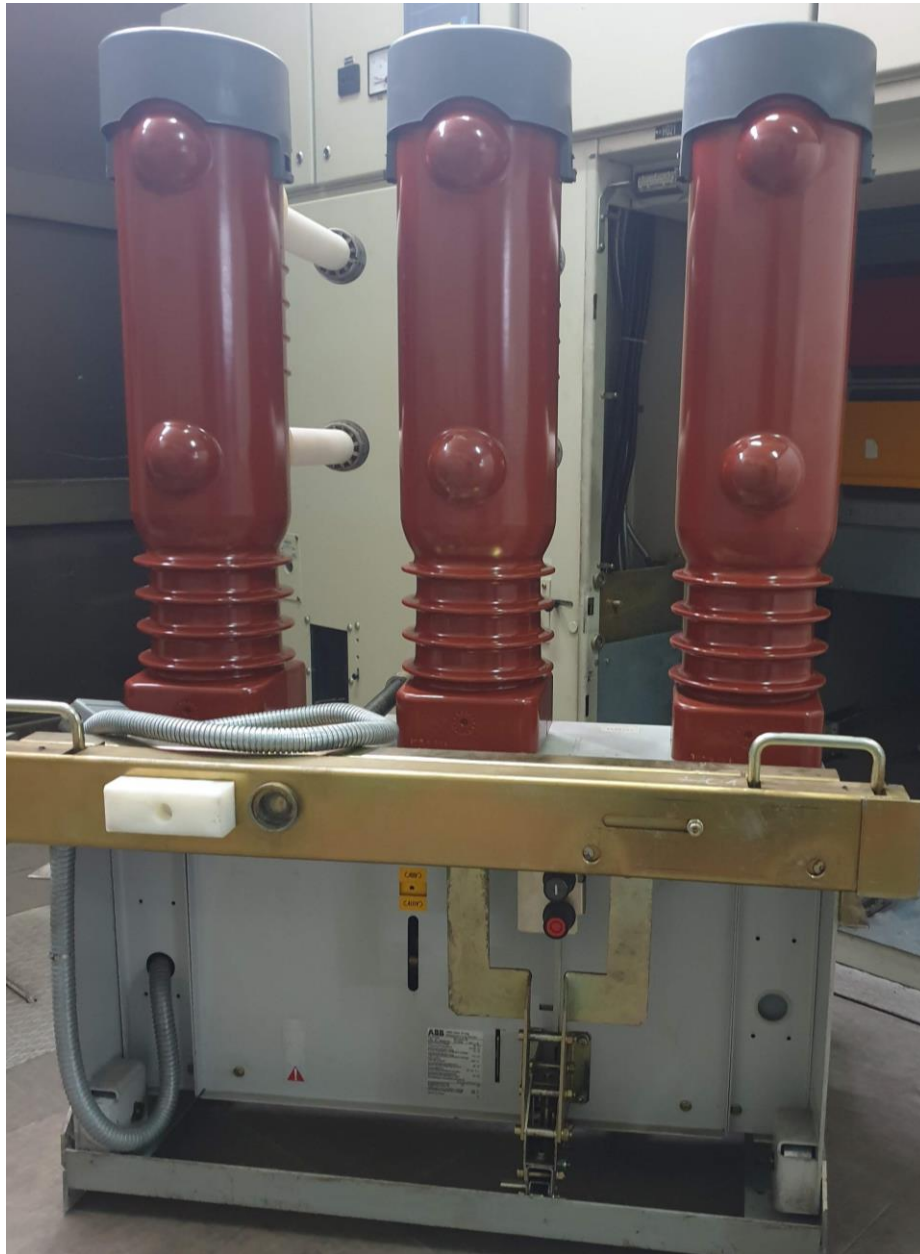
Slika 1.4.3 Izgled postojećeg prekidača u ćeliji H02 u TS Zenica 4 (prednja strana)
