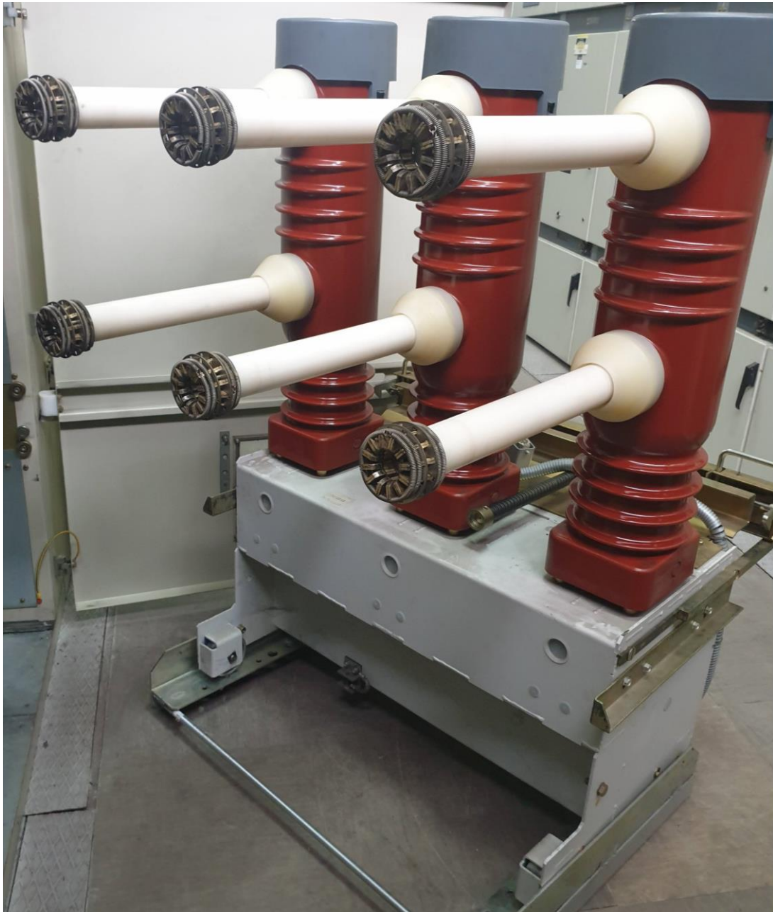
Slika 1.4.2 Izgled postojećeg prekidača u ćeliji H02 u TS Zenica 4
