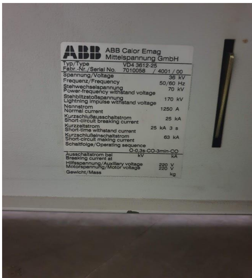
Slika 1.4.1 Natpisna pločica postojećeg prekidača u ćeliji H02 u TS Zenica 4
