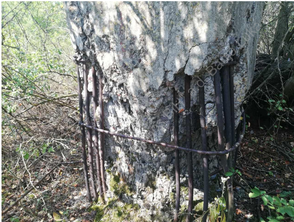
Fotografija oštećenja stuba br. 68
