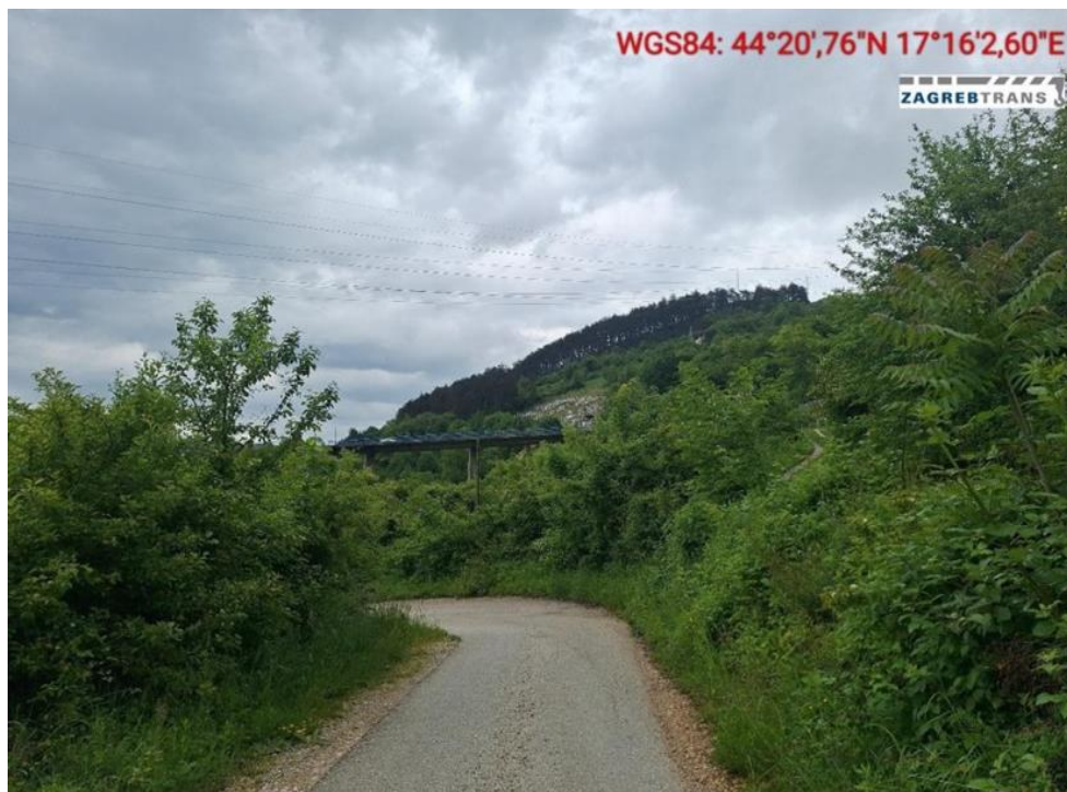
Slika 4- Pristupni put- potrebno očistiti unutrašnji radijus od stabala, grana, te proširiti put u unutrašnjem radijusu min. 3,50 m (ugraditi tampon i zbiti do potrebne zbijenosti)
