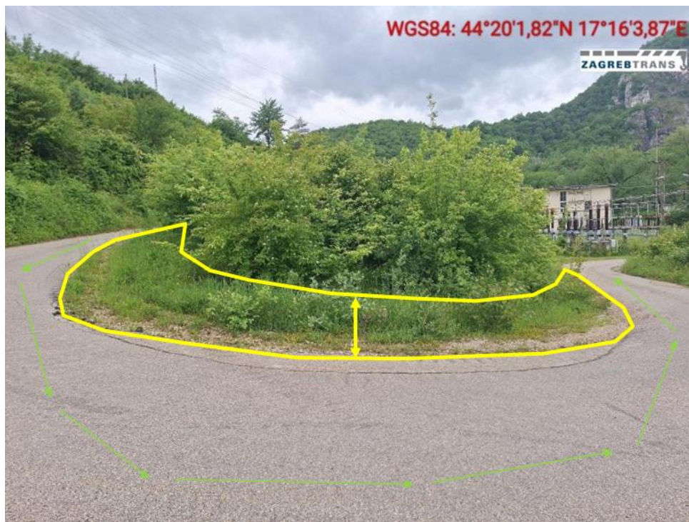
Slika 5- Pristupni put- potrebno očistiti unutrašnji radijus od stabala, grana, te proširiti put u unutrašnjem radijusu min. 3,50 m (ugraditi tampon i zbiti do potrebne zbijenosti), drugi pogled
