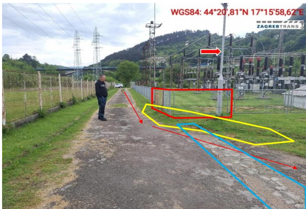
Slika 9- Potrebno ukloniti ogradu, rasvjetu te ukloniti ivičnjak, a zatim nasipati, poravnati te zbiti (60t/m 2 ) podlogu 1,5m od puta, takođe je potrebno provjeriti podlogu označenu plavom bojom zbog mogućnosti urušavanje, staviti čelične ploče ili sl.
