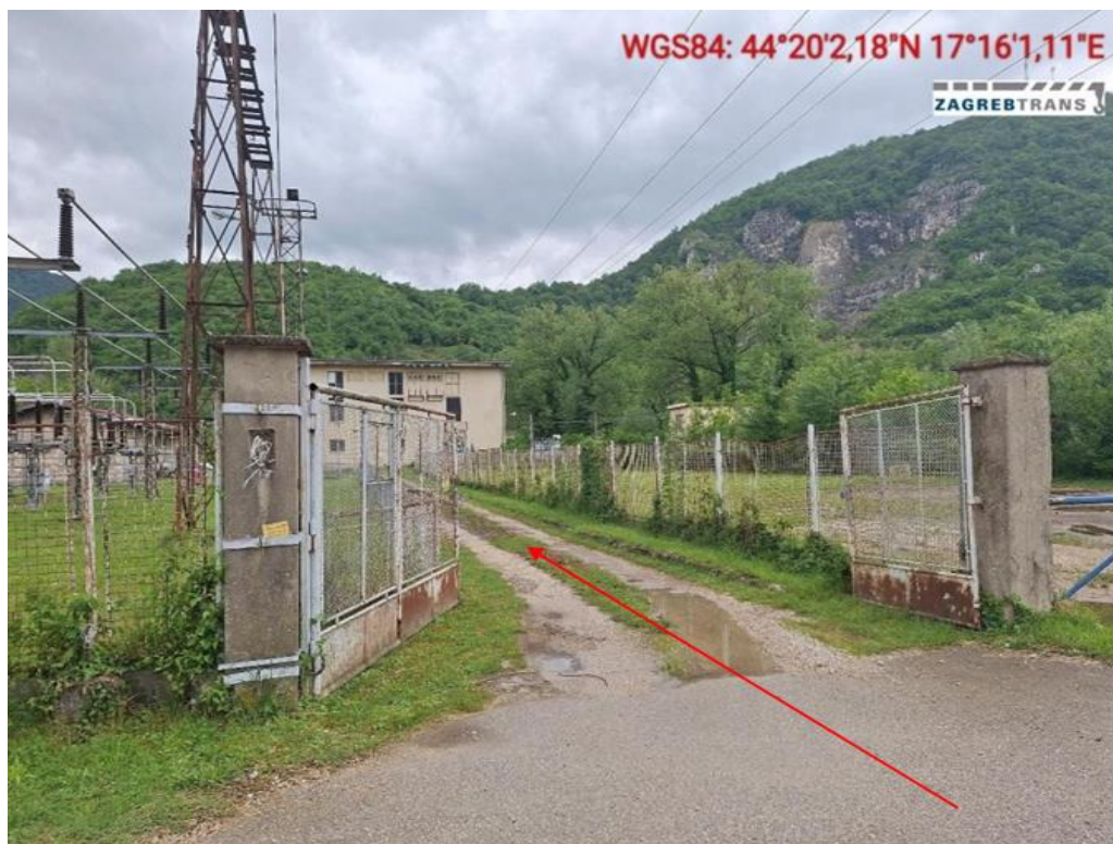
Slika 8- Ulaz u trafostanicu- potrebno nasuti, poravnati te zbiti tampon do potrebne zbijenosti za 60 t/m 2
