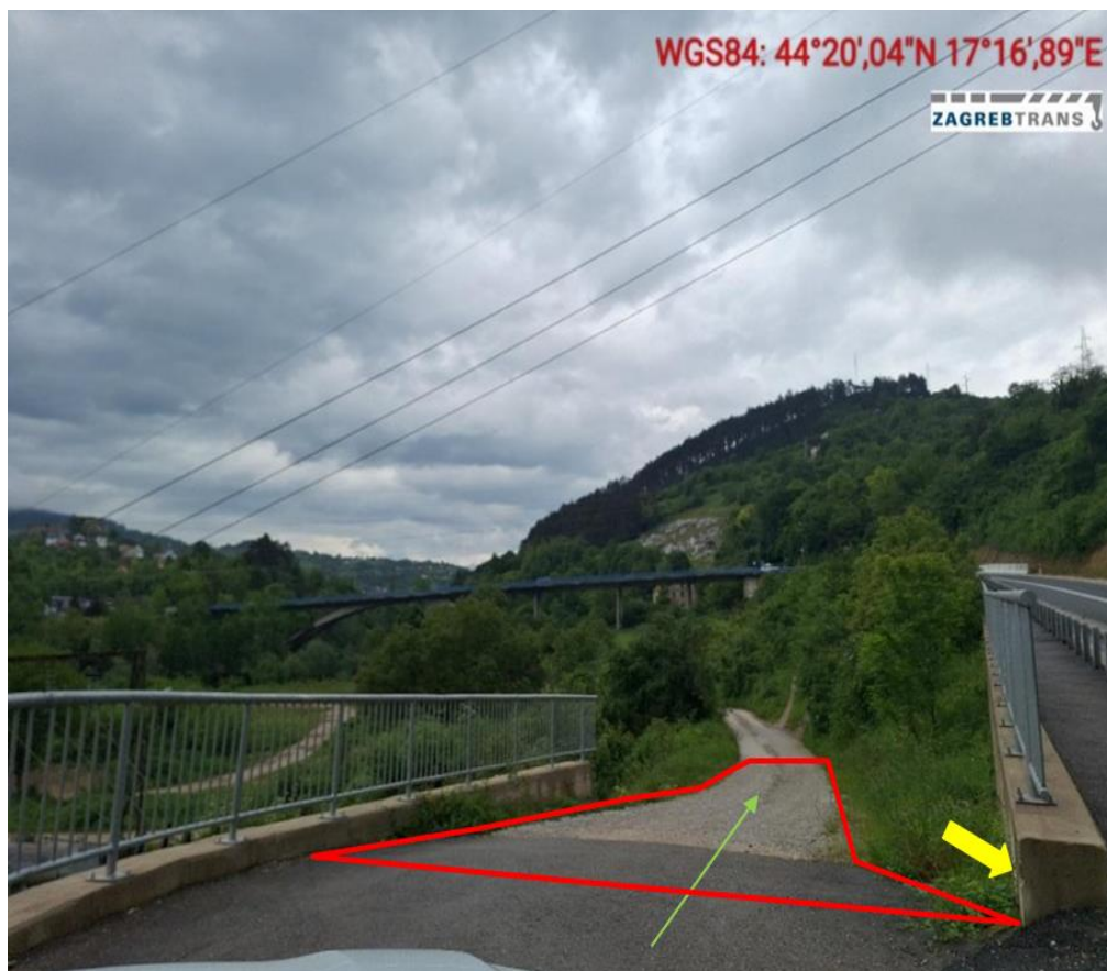
Slika 2- Ulaz sa glavne ceste- potrebno nasipanje i nabijanje ( 60 \text{ t/m}^2 ) materijala na ulazu zbog prevelikog pregiba
