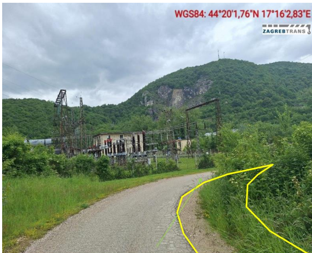
Slika 6- Pristupni put- potrebno očistiti unutrašnji radijus od stabala, grana, te proširiti put u unutrašnjem radijusu min. 2,00 m (ugraditi tampon i zbiti do potrebne zbijenosti)
