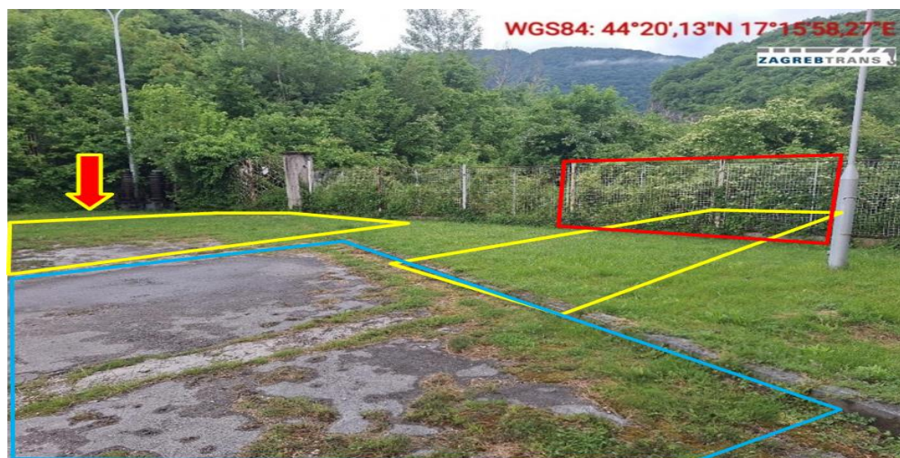
Slika 13-Mjesto istovara- ukloniti ivičnjake, ukloniti ogradu zbog proširenja 3,0m od ograde(nasuti, poravnati te zbiti tampon), mjesto istovara mora biti čisto, izravnato, te zbijeno do potrebne zbijenosti.
