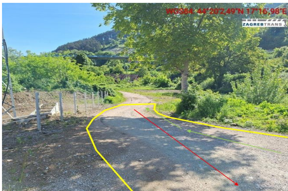
Slika 7- Pristupni put- Ugradnja, planiranje te zbijanje tampona do potrebne zbijenosti ( 60 \text{ t/m}^2 )
