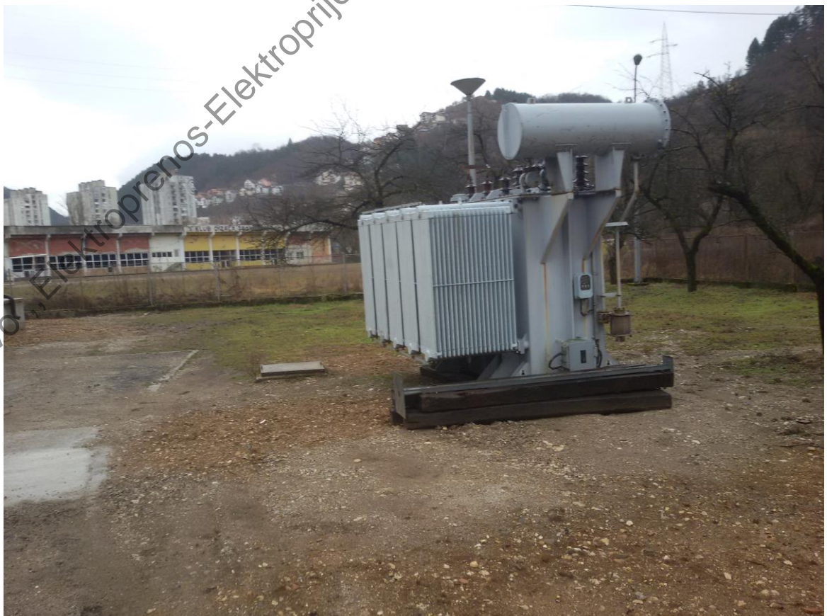
Slika 2. Transformator 35/10 kV, 8 MVA (TS Konjic); Pružni pragovi
