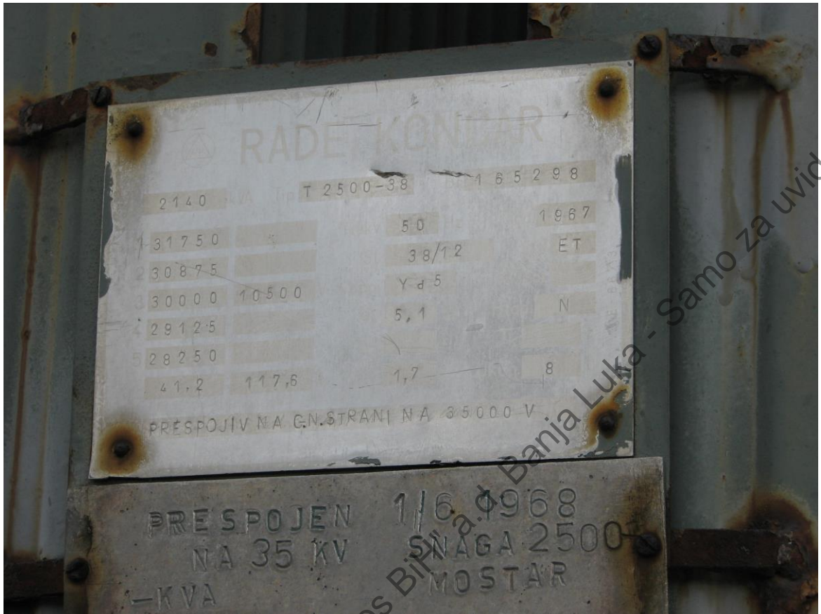
Slika 3. Transformator 35/10 kV, 2,5 MVA (TS Glamoč)
