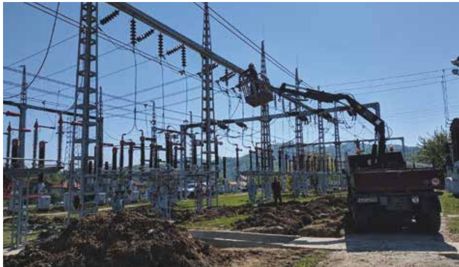
Slika 3. TS Zvornik – radovi u postrojenju 110 kV
