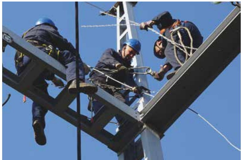
Slika 5. Elektromontažni radovi na portalu u TS Zenica 3
