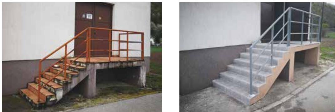
Slika 2. Prije i nakon sanacije stepeništa i podesta
