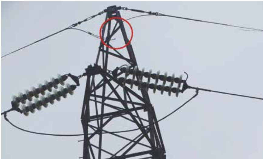
Slika 1. Prekid OPGW užeta na SM 15
