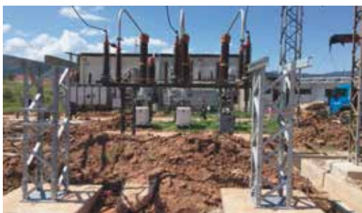
Slika 3. Radovi u DV polju 110 kV Goražde 1
