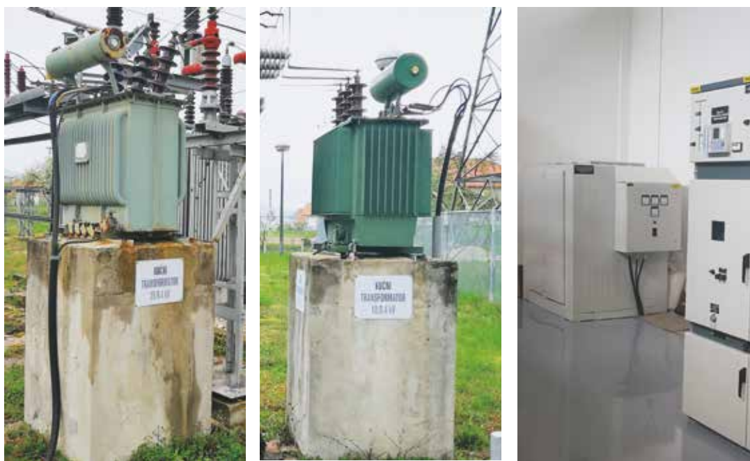
Slika 3. Kućni transformator 35/0,4 kV; Yz5; 100 kVA, kućni transformator 10(20)/0,4 kV; Dyn5; 250 kVA i novougrađeni kućni transformator 10(20)/0,4 kV; Yzn5; 100 kVA
