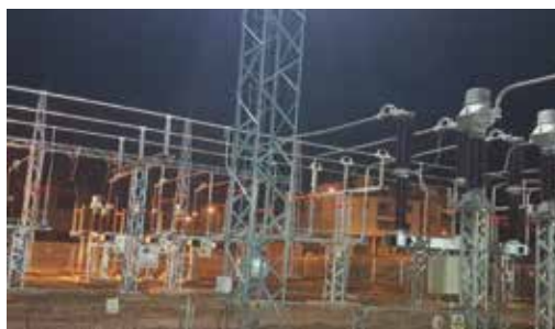
Slika 6. Postrojenje 110 kV nakon rekonstrukcije
