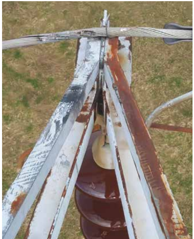
Površinsko oštećenje provodnog užeta koje je palo na donju konzolu
