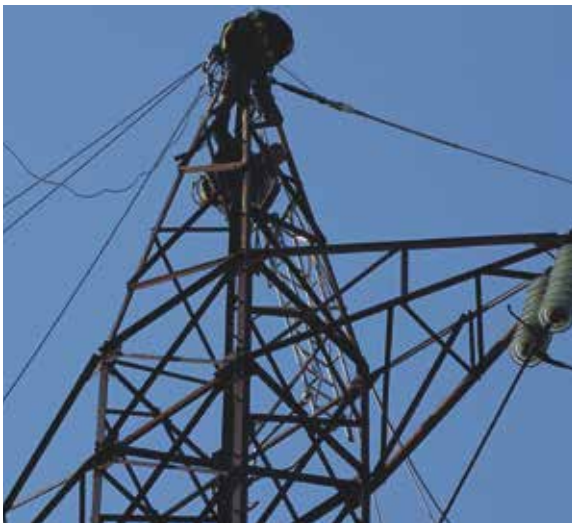
Slika 4. Elektromontažni radovi na SM 18
