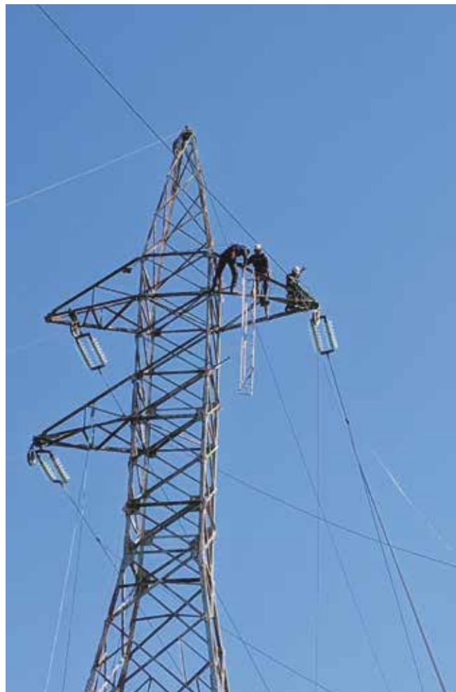
Slika 5. Radovi na demontaži faznih vodiča na DV 110 kV Ugljevik - Zvornik
