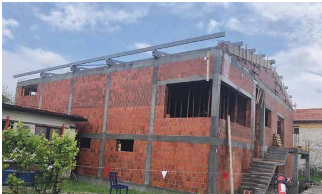
Slika 1. TS Bijeljina 1 – izgradnja komandno-pogonske zgrade
