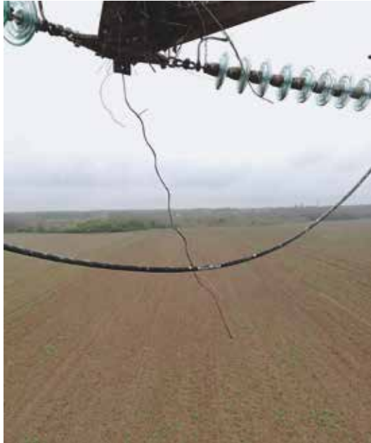
Graničica koja je uzrokovala ispad dalekovoda DV 110 kV Gradačac – Derventa – Brčko 2
