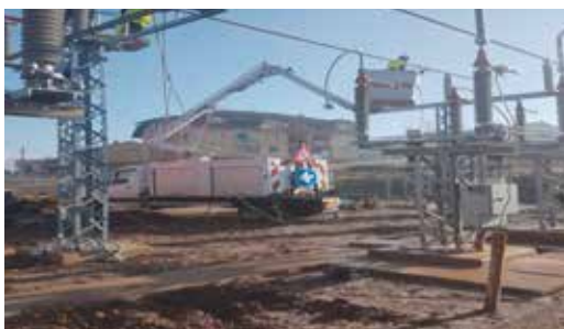
Slika 5. Montaža novog energetskog transformatora
