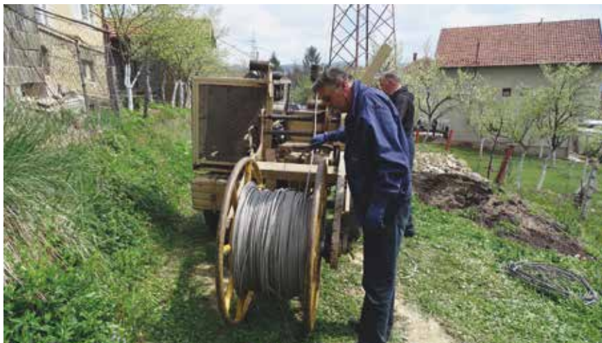
Slika 6. Priprema vučne mašine za elektromontažne radove kod SM 4
