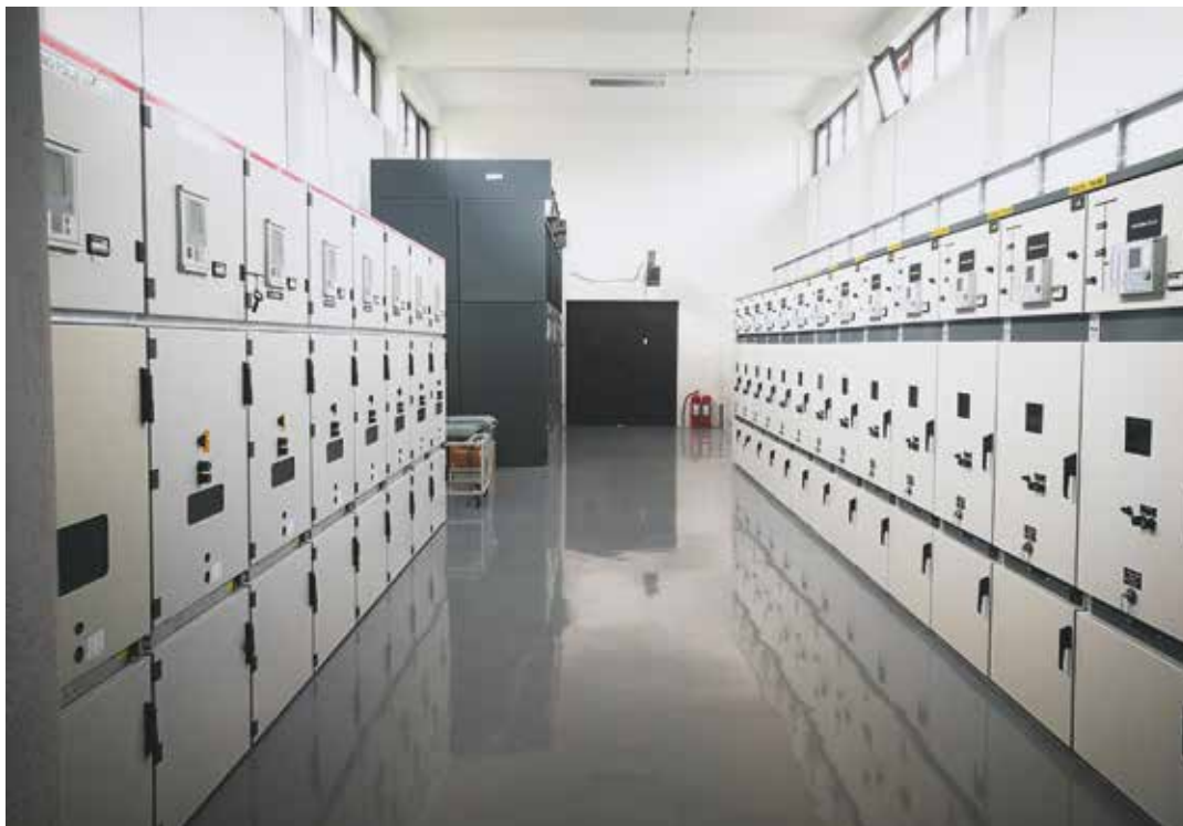
Slika 4. Pogonska prostorija nakon izvedenih radova
