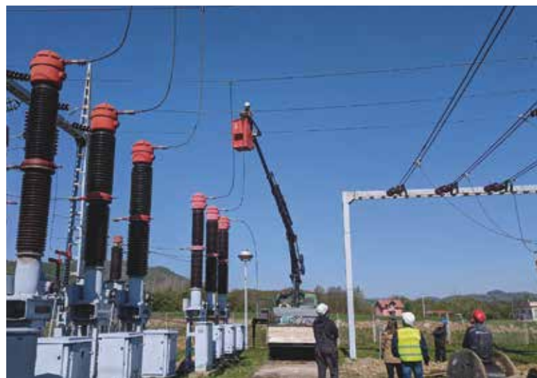
Slika 3. Demontaža stare opreme
