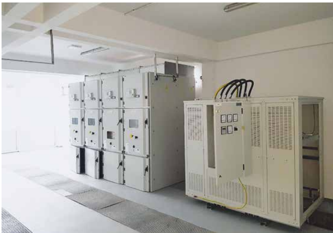
Slika 2. Finalni radovi na ugradnji postrojenja 10(20) kV i transformatorskog boksa sa kućnim transformatorom 10(20)/0,4 kV
