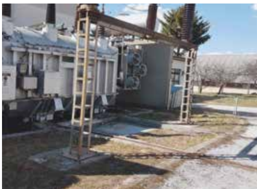
Slika 1 i 2. Izgled TS prije rekonstrukcije
