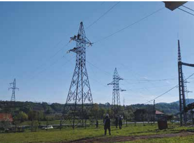
Slika 2. Radovi na demontaži faznih vodiča koji prelaze preko sabirnica 110 kV – Energotehnika Južna Bačka
