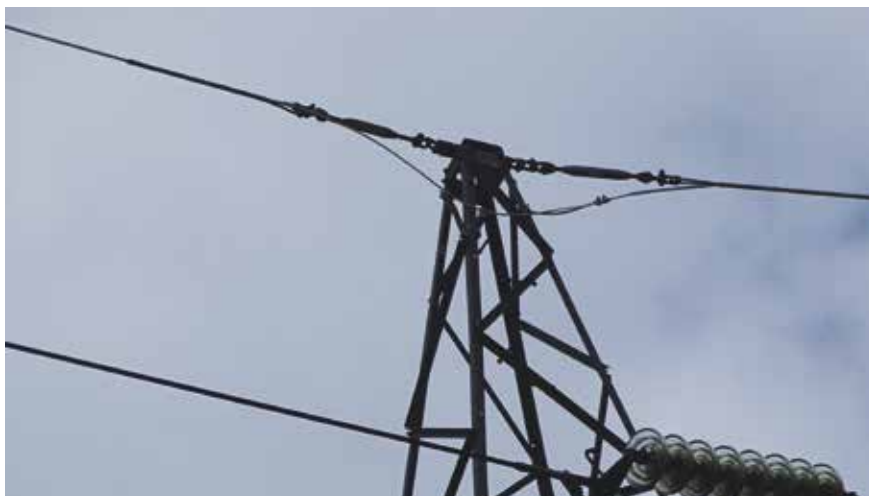
Slika 7. Novo OPGW uže na SM 15
