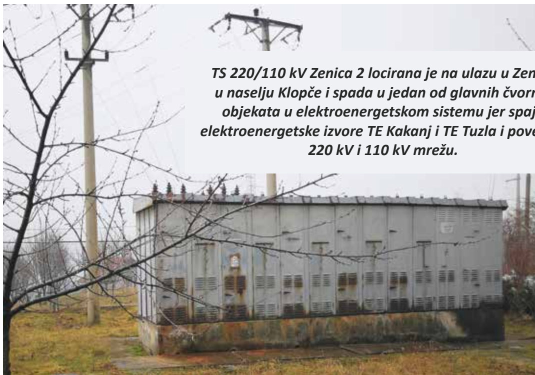
Slika 1. Postojeće BTS-R postrojenje 10/0,4 kV
