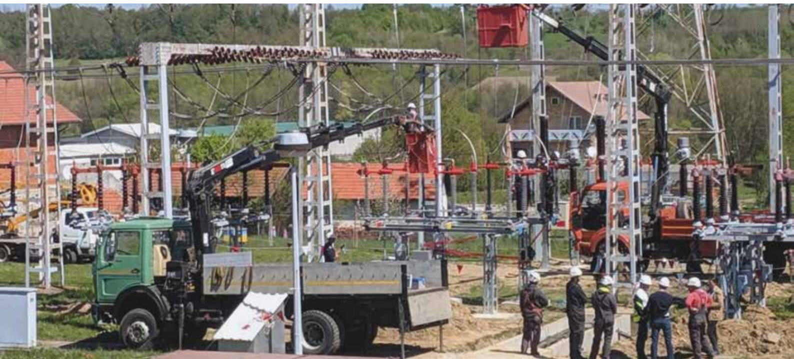
Slika 4. Radovi u postrojenju 110 kV za vrijeme totalnog zastoja sabirnica 110 kV
