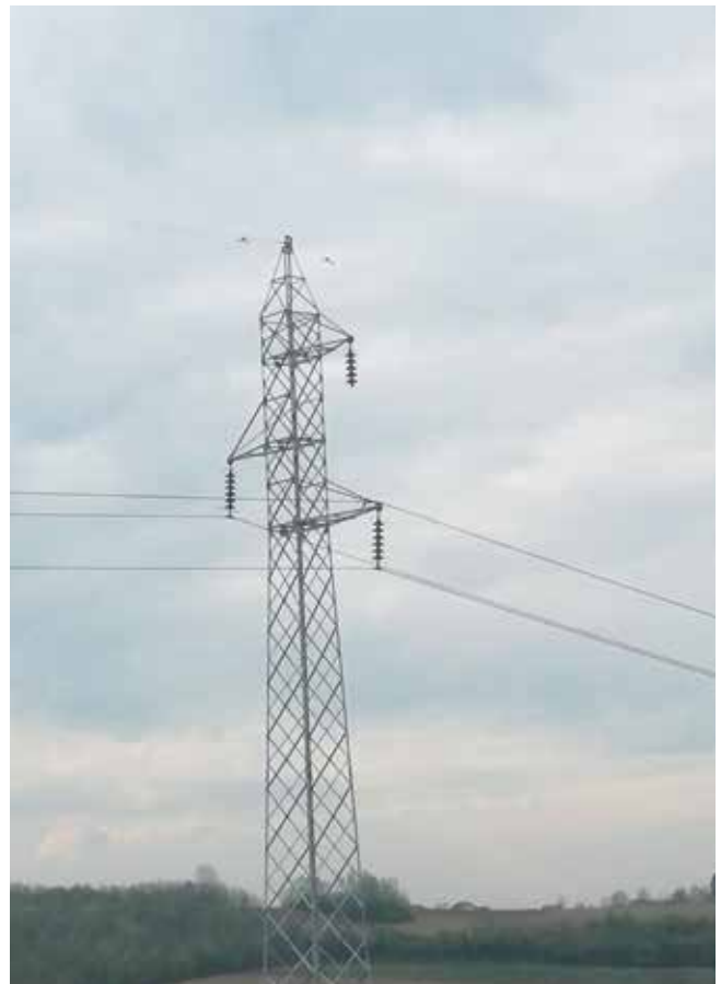
Prekid izolatorskog lanca na SM 24
