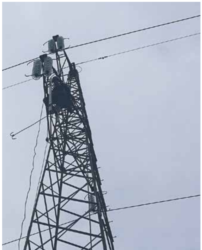
DV ekipa iz TJ Doboj na radovima sanacije prekida provodnog užeta
