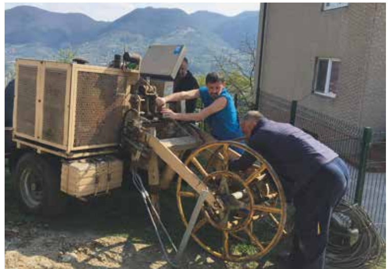
Slika 3. Priprema vučne mašine za elektromontažne radove kod SM 12
