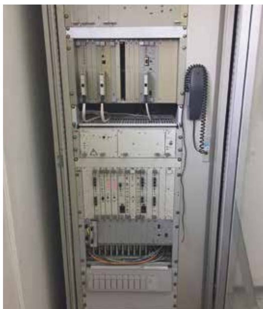
Ormar s VF opremom
