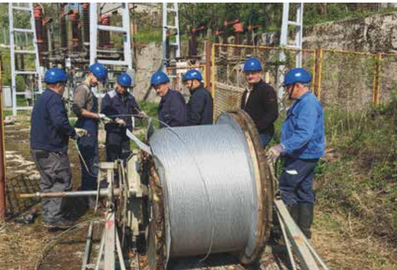
Slika 2. Priprema novog OPGW užeta za elektromontažne radove u TS Zenica 3
