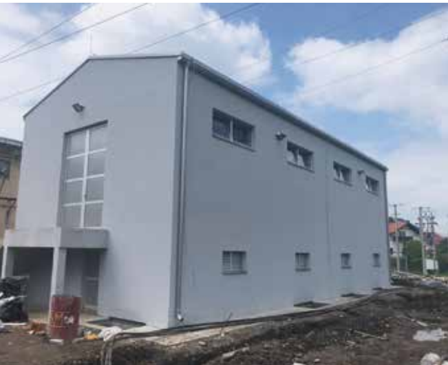
Slika 2. TS Teslić – nova zgrada postrojenja 10 kV
