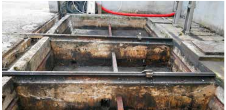
Uljna jama sa demontiranom rešetkom
