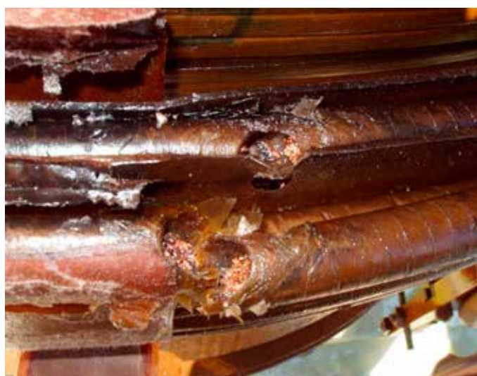
Proboj međuzavojne izolacije 110 kV namotaja transformatora T2
