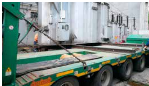
Izvlačenje i utovar starog energetskog transformatora
