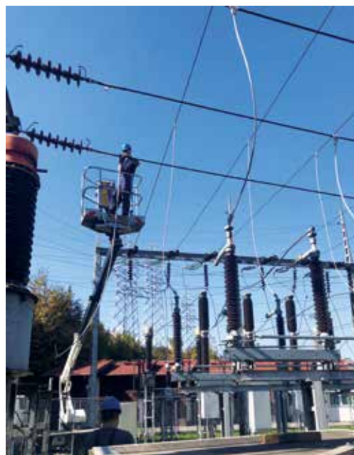
Zamjena NMT-a u mjernom polju 110 kV, sistem SII (TJ Tuzla)
