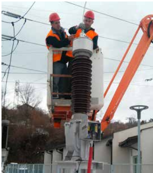
Stari i novi NMT 123 kV u DV polju 110 kV Tuzla 4
