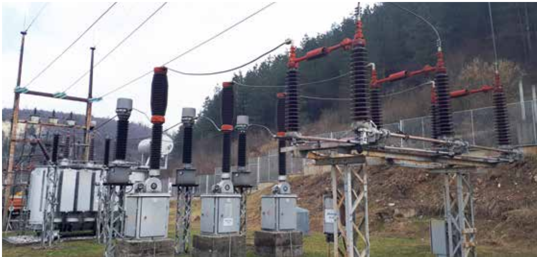
Izgled objekta prije rekonstrukcije
