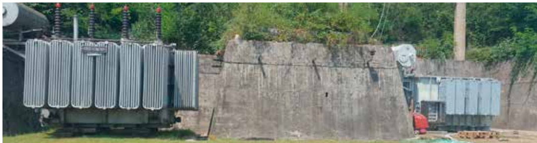
Stari transformator T1, 20 MVA (lijevo) i novi T1, 40 MVA
