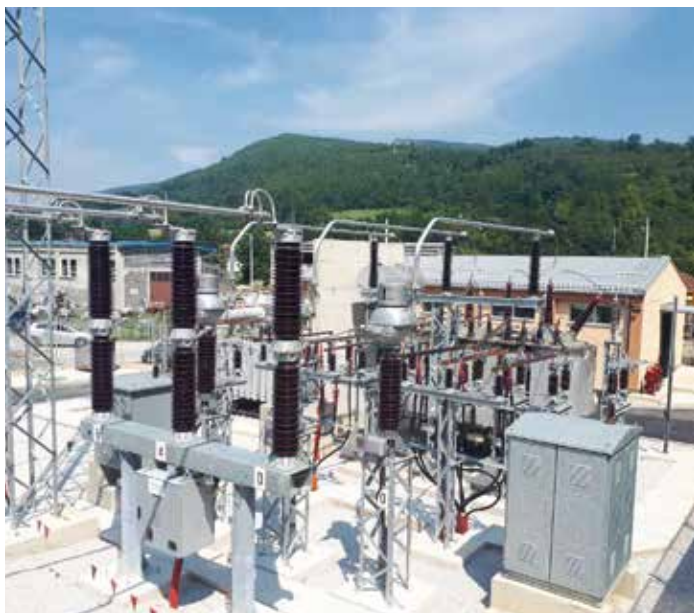
Transformatori i objekat u kojem je smješteno SN postrojenje
