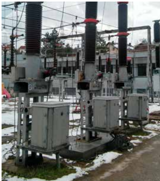
Stari i novi prekidač 123 kV u DV polju 110 kV Tuzla 4
