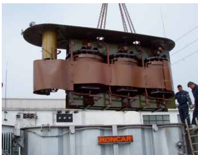
Vađenje aktivnog dijela iz kotla transformatora T2
