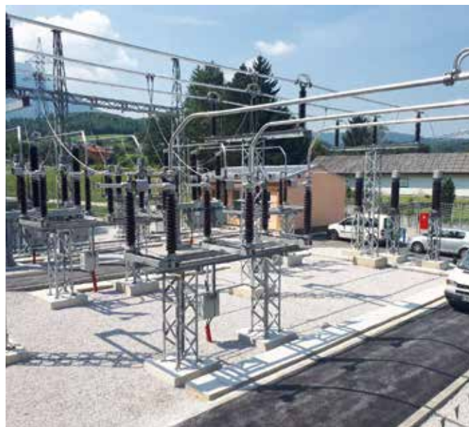
Dio VN postrojenja i objekat za upravljanje TS-om
