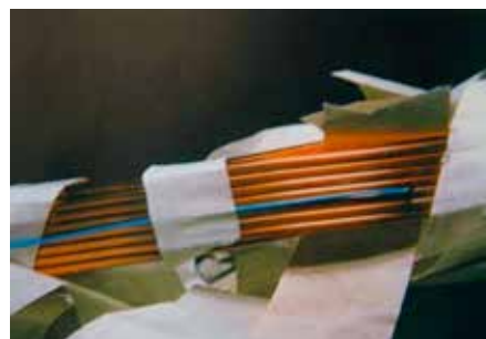
Slika 3. Senzor postavljen na namot transformatora [3]
