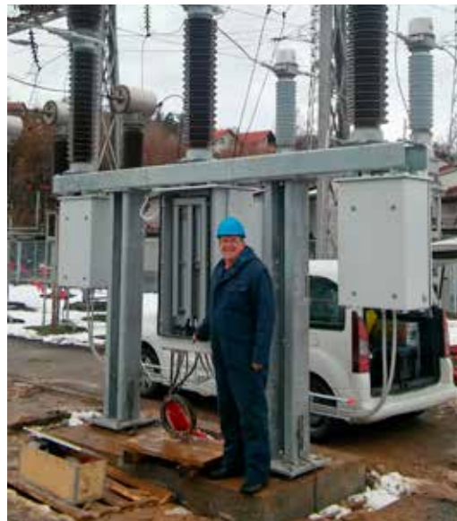
Stari i novi prekidač 123 kV u DV polju 110 kV Tuzla 4
