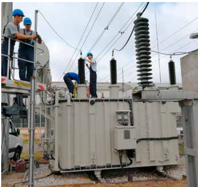
Povezivanje zvjezdista 110 kV transformatora T2 (TJ Doboj)
