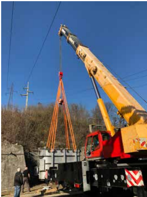
Utovar transformatora za prevoz
