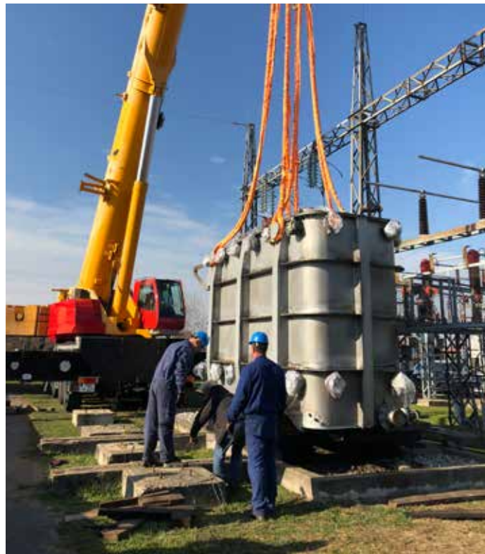
TS Brčko 2 – postavljanje zamjenskog transformatora
