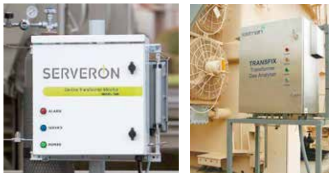
Slika 1. Primjeri ugradnje monitora za gasove (Serveron, Transfix) [6, 7]
