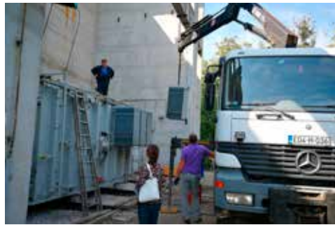
Montaža prateće opreme novog energetskog transformatora
