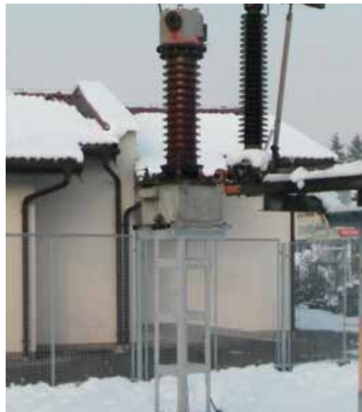
Stari i novi NMT 123 kV u DV polju 110 kV Tuzla 4
