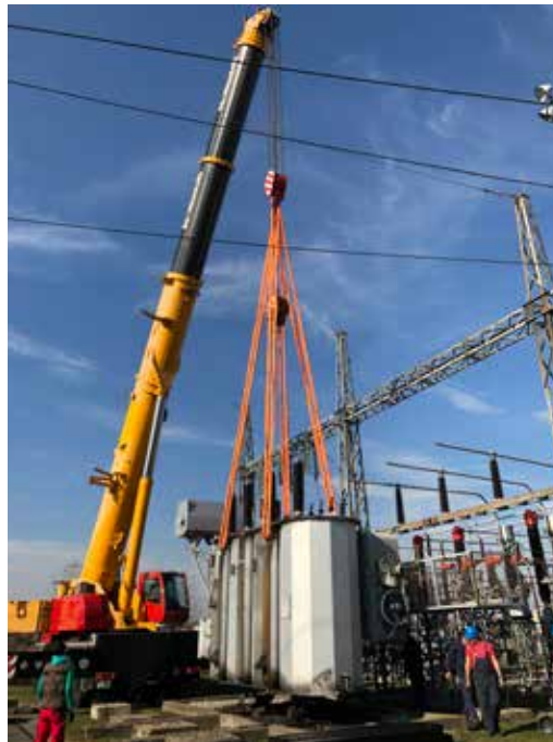
Istovar i postavljanje zamjenskog transformatora
