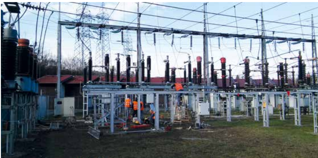
Novi sabirnički rastavljači 123 kV sistema SI i SII 110 kV u DV poljima Tuzla 3 i Tuzla 5
