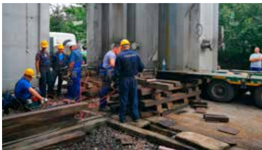
Izvlačenje i utovar starog energetskog transformatora
