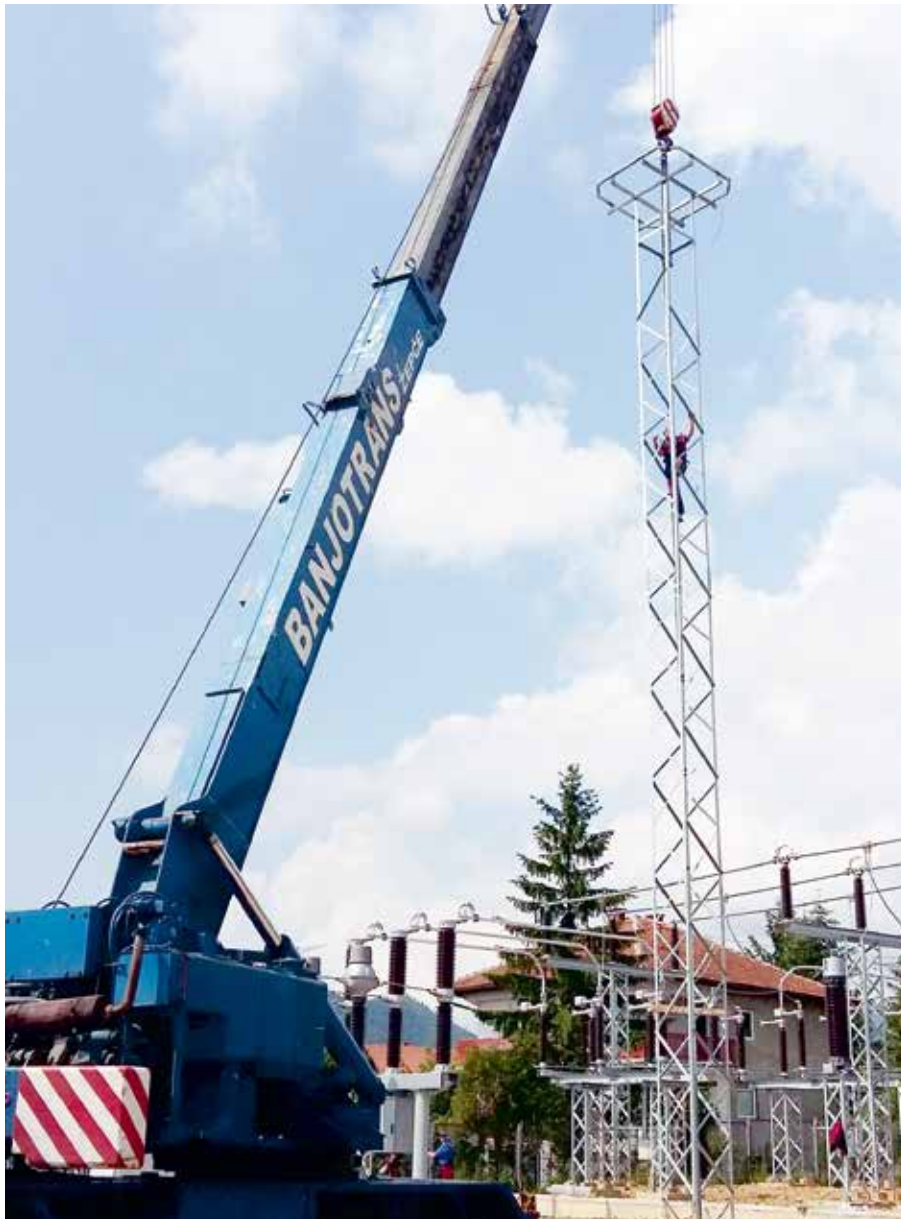
Montaža reflektorskog stuba
