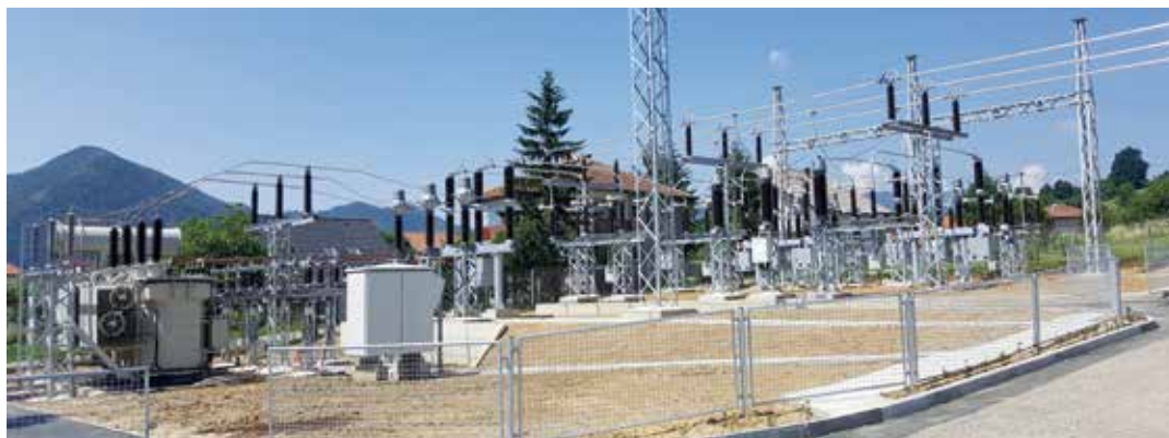
TS Žepče 110/x kV po okončanim radovima
