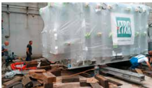
Istovar i pozicioniranje na šine novog energetskog transformatora
