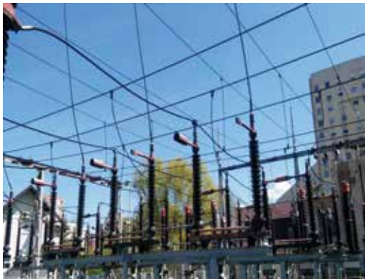
TS Tuzla Centar – vanjsko postrojenje 110 kV, sabirnice 110 kV, sistem SI
