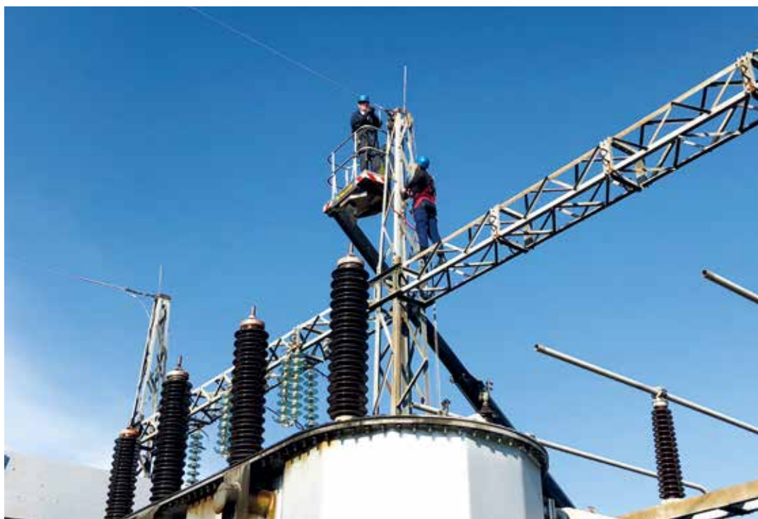
Demontaža zaštitinog užeta na DV 110 kV Brčko 1 – Brčko 2
