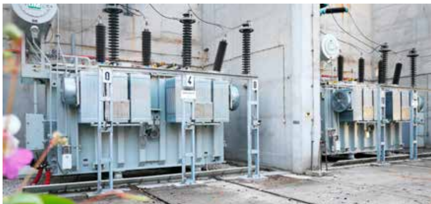
Novi energetska transformatori
