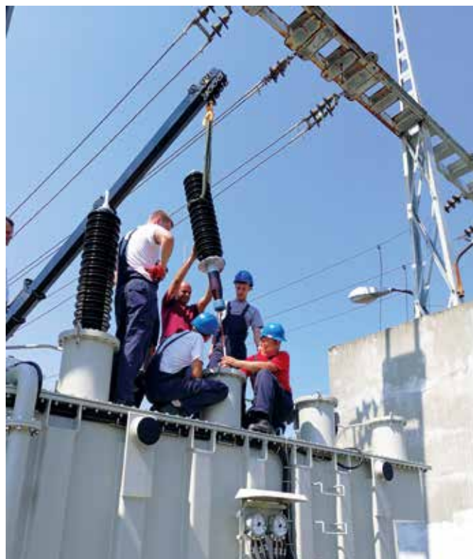
Montaža provodnih izolatora 110 kV transformatora T2 (TJ Tuzla i TJ Doboj)
