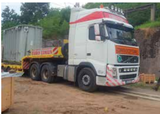
Istovar novog transformatora T1 110/35/10(20) kV
