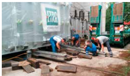
Istovar i pozicioniranje na šine novog energetskog transformatora
