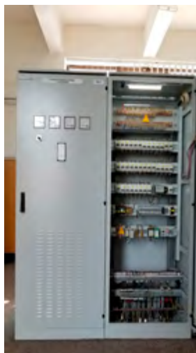
Slika 2. Novi sistem pomoćnog napajanja u TS
