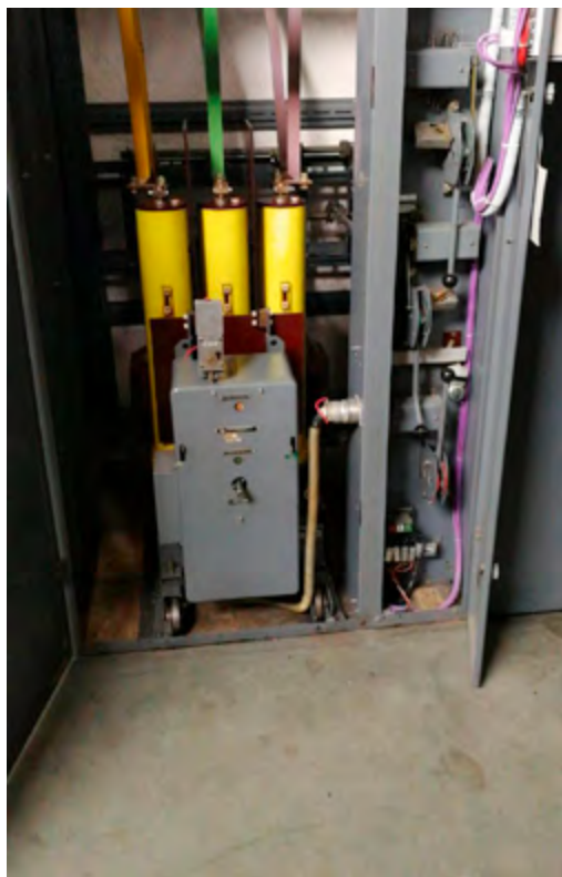
Stari malouljni prekidač koji je predmet zamjene
