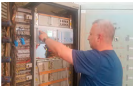
Slika 4. Sukcesivna zamjena zaštitno-upravljačkih uređaja 10 kV odvoda
