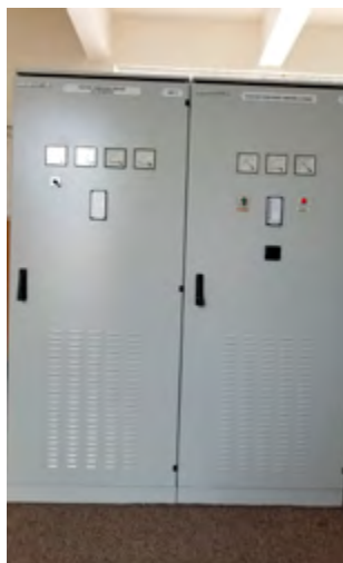
Slika 2. Novi sistem pomoćnog napajanja u TS
