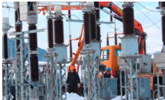
Demontaža zaglavljene pola prekidača
