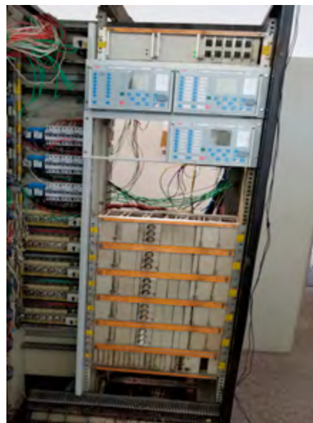
Slika 4. Sukcesivna zamjena zaštitno-upravljačkih uređaja 10 kV odvoda
