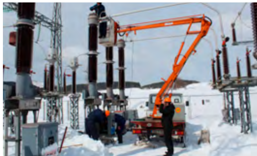
Radovi na defektaži kvara na prekidaču HPGE 11A/16 u polju DV 110 kV Knin u TS 110/35/10 kV Bosansko Grahovo
