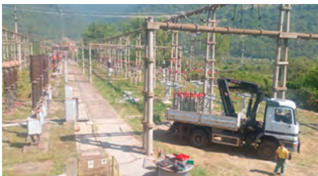
Radovi na zamjeni rastavljača
