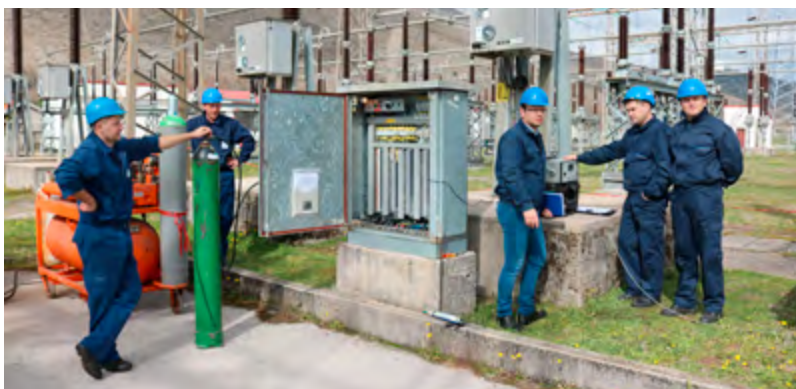
Ispiranje komore prekidača pomoću dušika (N)
