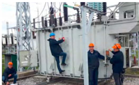
Radovi na reviziji energetskog transformatora
