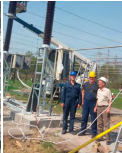
TS Tuzla 4 – sanacija
