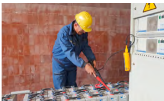
Испитивање акумулаторске батерије
