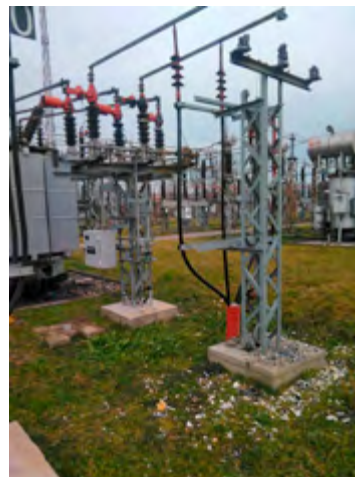
Havarisani dio postrojenja, izlazna 35 kV strana transformatora T3
