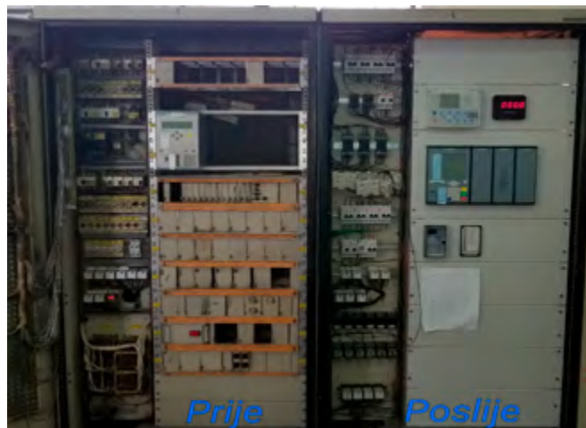
slika 8. Ormar zaštite i upravljanja transformatora 110/10 kV i polja DV110 kV prije i poslije zamjene
