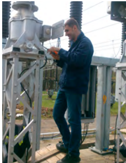
TS Tuzla 4 – sanacija
