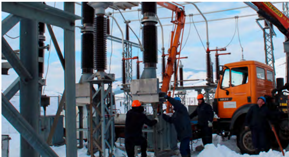
Montaža rezervnog ispravnog pola prekidača uz tehničku podršku kolege iz TJ Banja Luka
