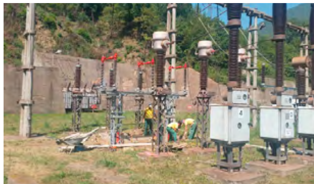
Građevinski radovi na temeljima VN aparata
