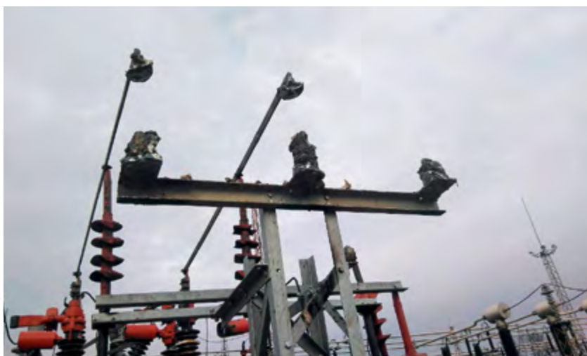
Havarisani dio postrojenja, izlazna 35 kV strana transformatora T3
