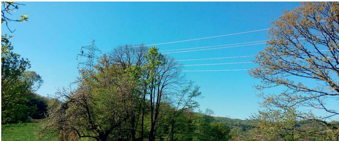
Izvođenje radova na priključnom DV/KV 2x110 kV za TS Tuzla 3
