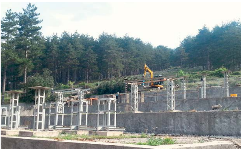
Постројење 110 kV у току реконструкције
