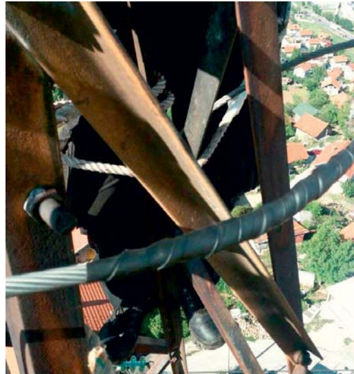
Saniranje oštećenog OPGW kabla na prolazu zateznog stuba SM 13
