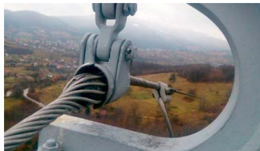
Nakon sanacije nosnog ovješnja i veze uže–stub na SM 11
