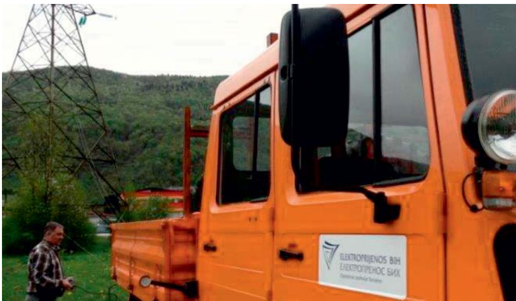
Saniranje oštećenog faznog vodiča ubacivanjem novog komada užeta
