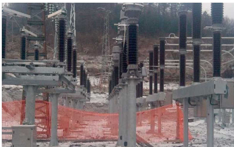
Стање у току реконструкције
