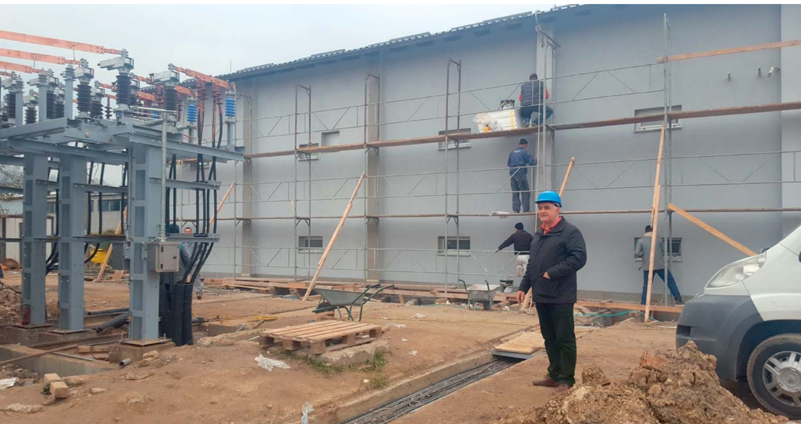
Radovi u postrojenju 110 kV i na novoj komandno-pogonskoj zgradi – Armin Hrustić
