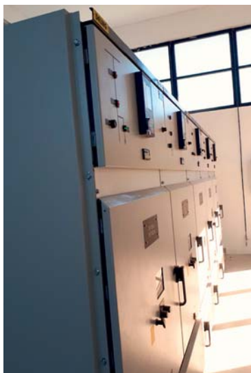
Izgled novougrađenih 35 kV ćelija u obnovljenoj pogonskoj zgradi
