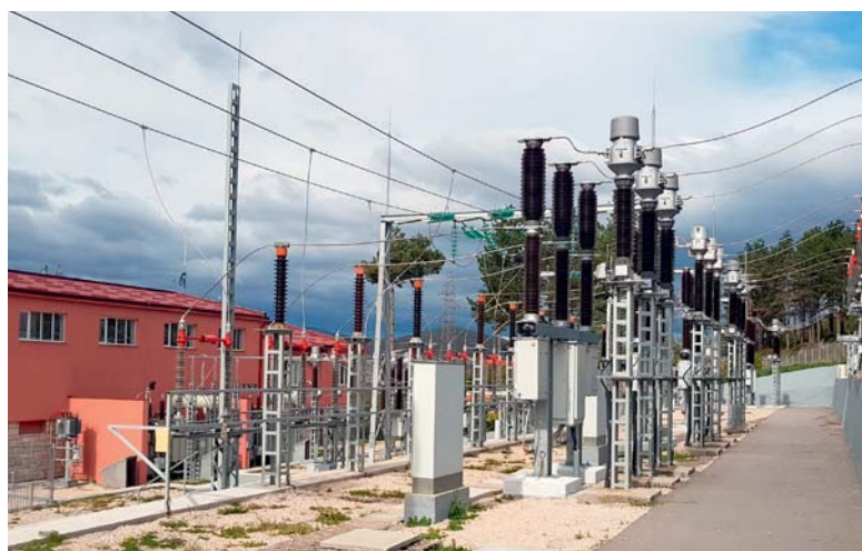
Постројење 110 kV и КПЗ након реконструкције
