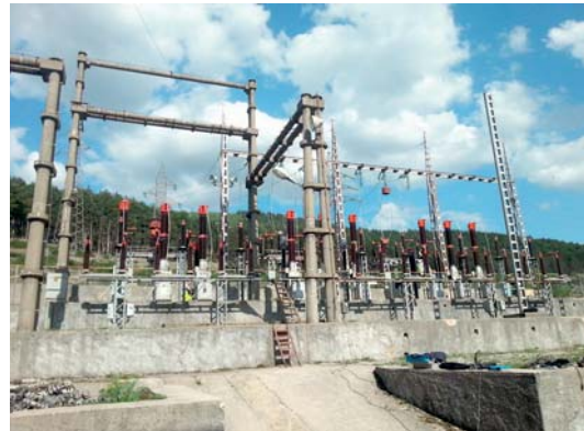
Постројење 110 kV прије реконструкције
