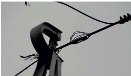
Oštećenje nosnog ovješnja i veze uže–stub na SM 11
