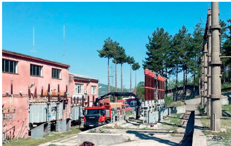
Постројење 110 kV и КПЗ у току реконструкције
