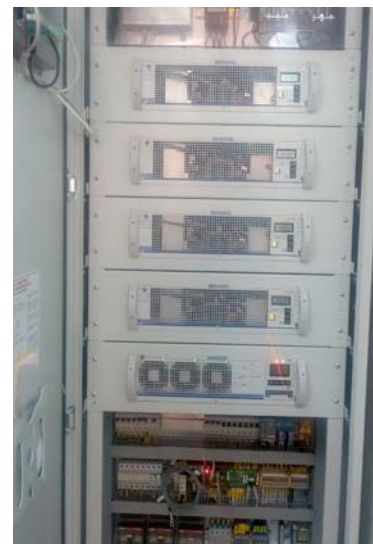
Novi ispravljač i inverter za obezbjeđenje pomoćnog napajanja TS Tuzla 4
