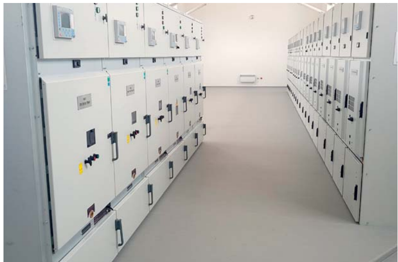
СН постројење након реконструкције
