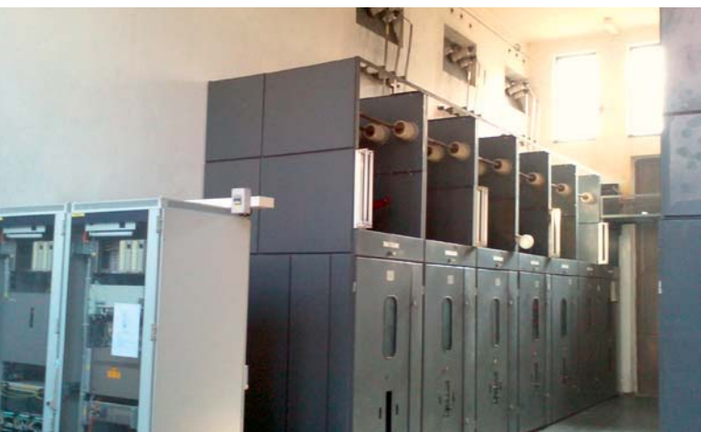
Средњенапонско постројење прије и након реконструкције
