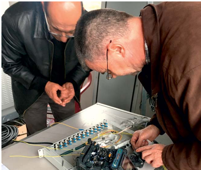
Spajanje POK-a i ODF-a u TS HAK (izvođač Energoinvest d.d.)
