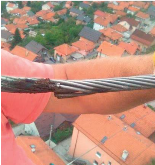
Oštećenje OPGW kabla na prolazu zateznog stuba SM 13
