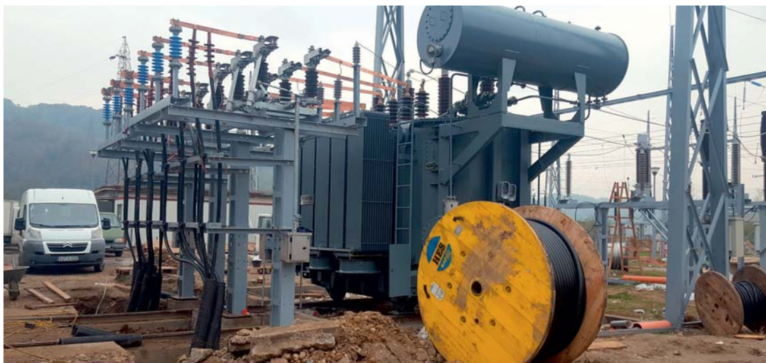
TS HAK - montiran novi energetski transformator T20
