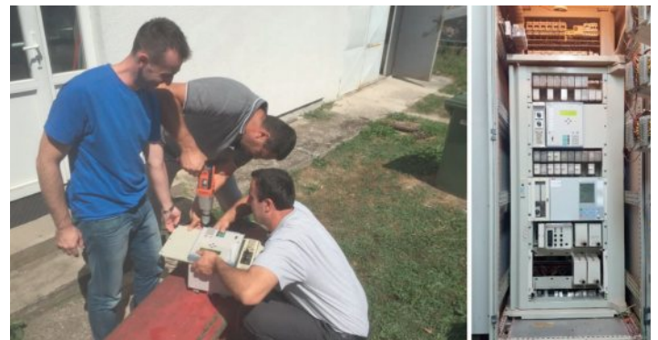
TS Travnik 1 - radovi na zamjeni zaštite polja DV 110 kV Travnik 2 (Ahmed Pleh, Senad Pandžić i Muhamed Zildžo)
