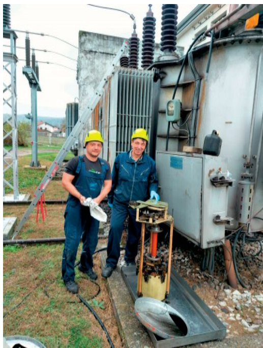
Izvodači radova pri radu na inspekciji na TR 1 u TS Modriča; ASEA tip: U CFDN 650/300, iz 1980. godine
