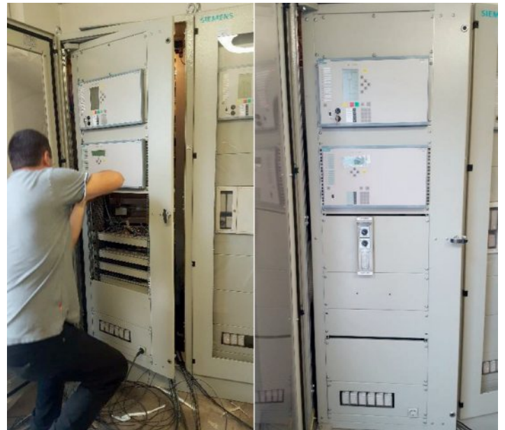
TS Zenica 1 - radovi na zamjeni zaštite polja DV 110 kV Travnik 1
