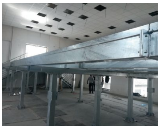
Монтажа челичнорешеткасте конструкције у погонској просторији
