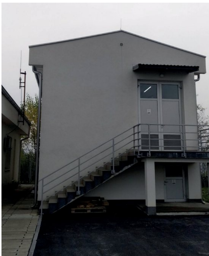
Pogonska zgrada postrojenja 35 kV
