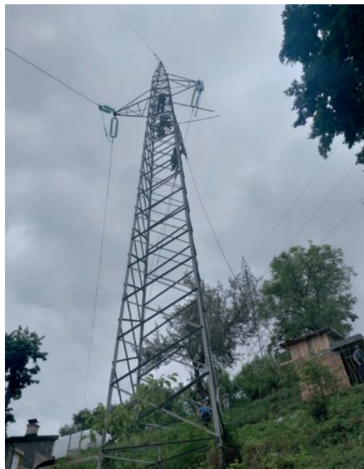
Slomljena donja konzola, prekinuti vodiči gornje i donje faze SM 7 – SM 8 i oštećen vodič donje faze SM 6 – SM 7
