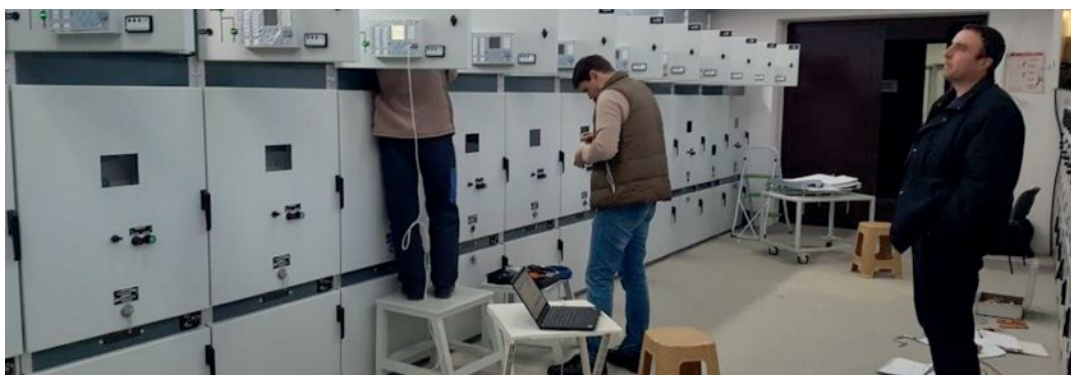
Projekat proširenja SN 10(20)kV postrojenja u TS Novi Travnik
