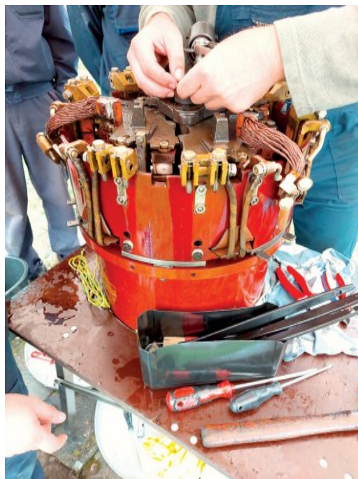
Rad na teretnoj preklapci na TR 1 u TS Doboj 2; ELTA tip: PO-250 iz 1978. godine
