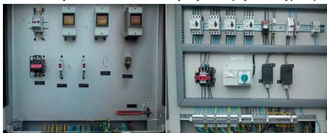
ТС Рогатица, Т1_110/10/35 kV – Ормар прије и после реконструкције
