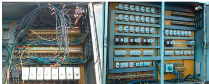
ТС Вишеград, Т1_400/110 kV – Ормар после реконструкције
