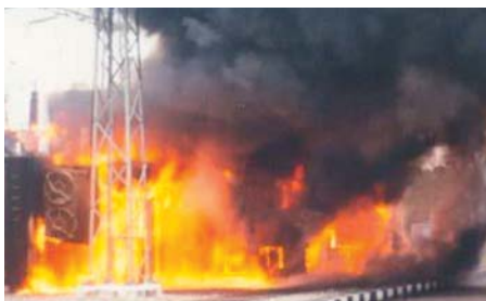
Slika 1. Požar uzrokovan kvarom OIP provodnog izolatora
