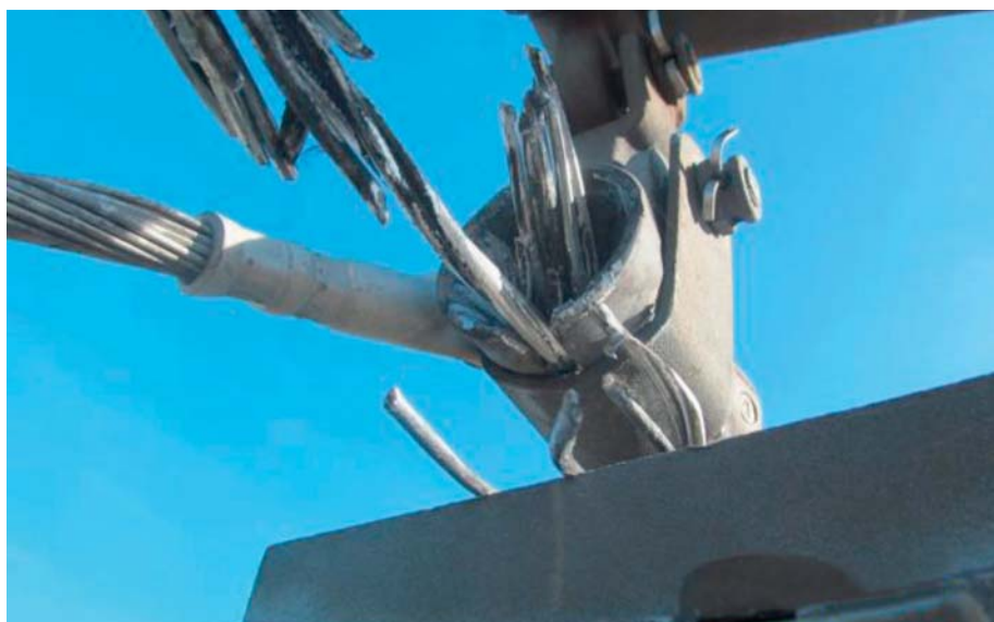
Oštećeni OPGW na SM 9
