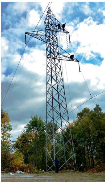
Sanacija oštećene konstrukcije stupa br. 63. DV 220 kV Tuzla–Đakovo
