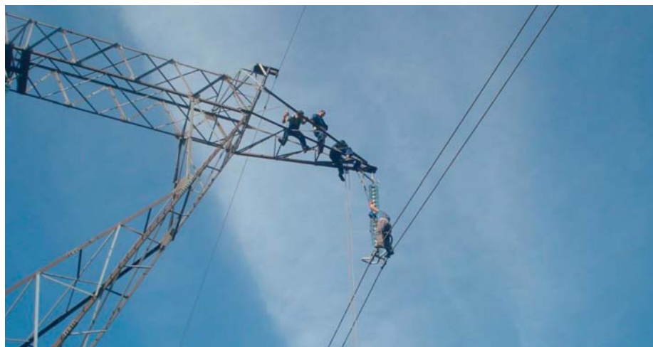
Radovi na DV 400 kV TS Sarajevo 20 – Buk Bijela
