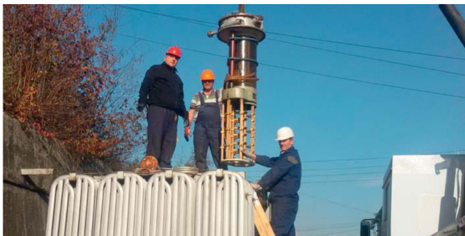
TS Lukavac – demontaža korisne opreme sa transformatora koji je otpisan
