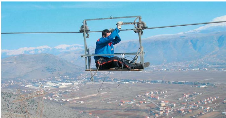
Popravak faznih vodiča iz radnih kolica
