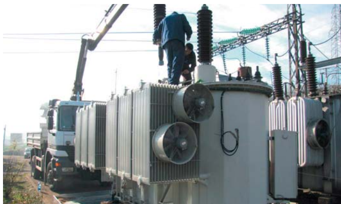
Montaža T1.1 u TS Tešanj
