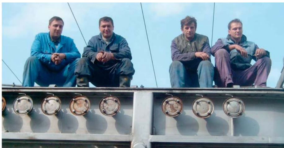
„Trafoekipa“ spremna za početak radova (Muamer Mašić – poslovođa, Enes Kumro, Nihad Eminagić, Almir Bojčić)
