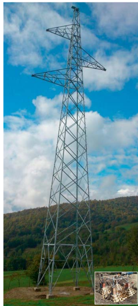
Izgradnja dalekovoda 110 kV TS Visoko – TS Fojnica
