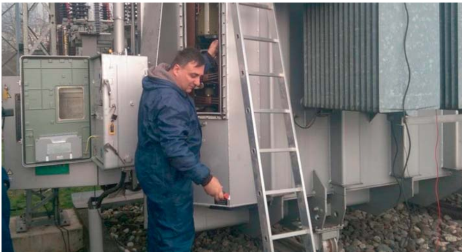
TS Zavidovići – intervencija na biračkom dijelu regulacione sklopke
