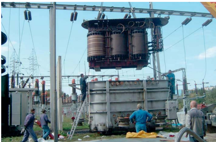
TS Tuzla Centar – vraćanje aktivnog dijela transformatora u kotao nakon sanacije
