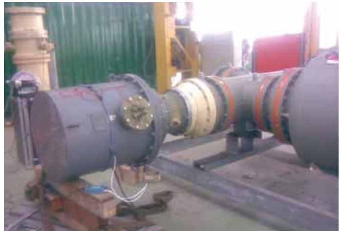
Mjerenje parcijalnih pražnjenja na strujnom transformatoru, na naponskom transformatoru u metalom oklopljenom postrojenju i na improvizovanom pristroju u laboratoriji.
