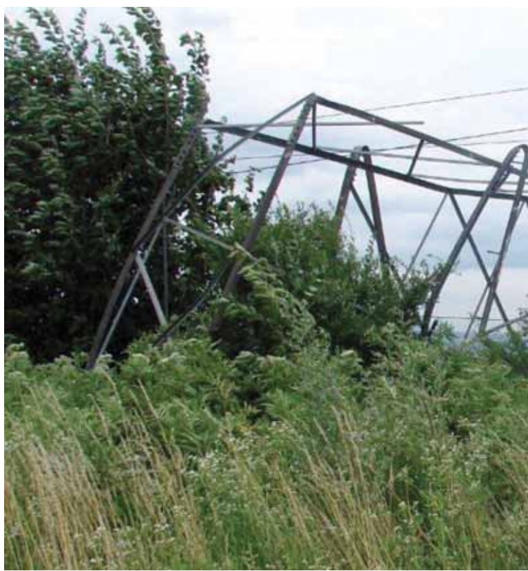
SMAKNUTA KONSTRUKCIJA NAKON OTUĐENJA DIJELOVA DALEKOVODNOG STUBA
