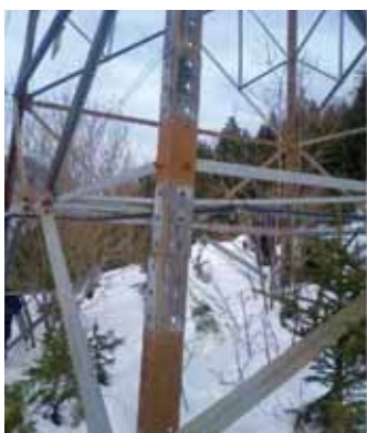
SMAKNUTA KONSTRUKCIJA NAKON OTUĐENJA DIJELOVA DALEKOVODNOG STUBA
