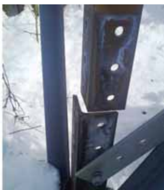
SMAKNUTA KONSTRUKCIJA NAKON OTUĐENJA DIJELOVA DALEKOVODNOG STUBA
