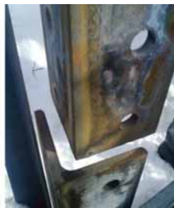
SMAKNUTA KONSTRUKCIJA NAKON OTUĐENJA DIJELOVA DALEKOVODNOG STUBA
