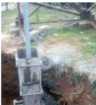
Sanaciji temelja i antikorozivna zaštiti stubova DV110 kV TE Tuzla – Lukavac/I.
