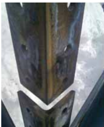
SMAKNUTA KONSTRUKCIJA NAKON OTUĐENJA DIJELOVA DALEKOVODNOG STUBA
